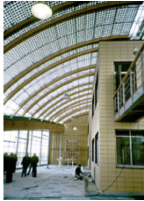
Şekil 5.10: Eğrisel çatıda güneş pili paneli uygulama örneği (Hollanda)
