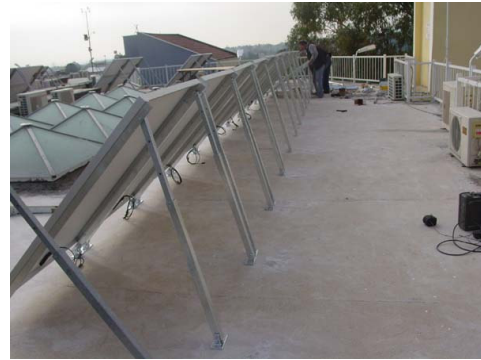
Şekil.1.1: Ege Üniversitesi tarafından gerçekleştirilen düz çatı üzerine güneş pili paneli uygulaması. [3]
