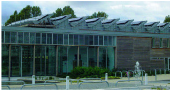
Şekil 3.13: Testere dişli çatı üzerinde güneş pili panel uygulaması
