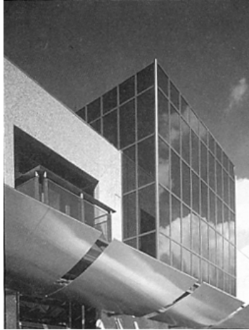
Şekil 3.5: A.P.S. giriş bloğu görünüşü
