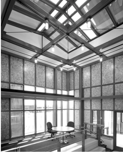
Şekil 3.6: Giriş bloğu üzerindeki güneş pili panellerinden oluşturulan giydirme cephe ve çatı ışıklığının iç mekandaki günışığı düzeyine etkisi
