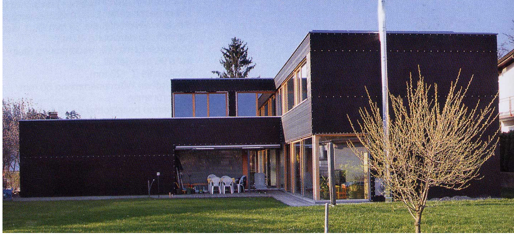
Şekil 3.15: Müstakil konut düz çatısına güneş pili paneli uygulaması (Avusturya)
