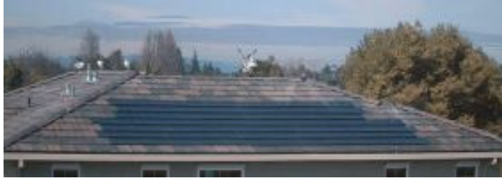
Şekil 3.10: Clarum’da gerçekleştirilen güneş pili çatı levha kaplama uygulaması
