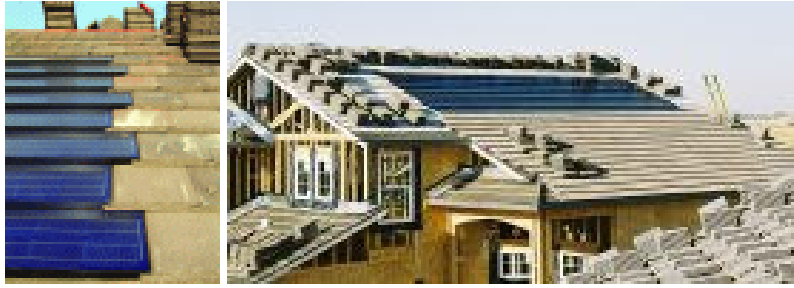
Şekil 3.11: Clarum’da güneş pili çatı levha kaplamasının uygulandığı.
