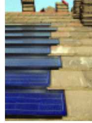
Şekil 5.7: Eğik çatılarda güneş pili parçalı çatı kaplama uygulama örnekleri (Bölüm 3.2.6)
