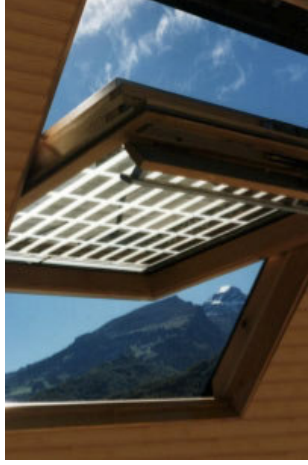
Şekil 5.15: Çatı penceresine yarı saydam güneş pili panel uygulama örneği (Bölüm 3.2.9) [19]
