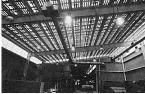
řekil 3.8: Rikers Adası Geri Dnřm Tesisi Gneř Pili atı Sistemi
