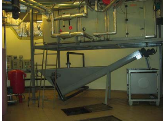
Şekil 5.18 : Atıksu içerisinde sıyrılan yağ (zehirli atık) tankı
