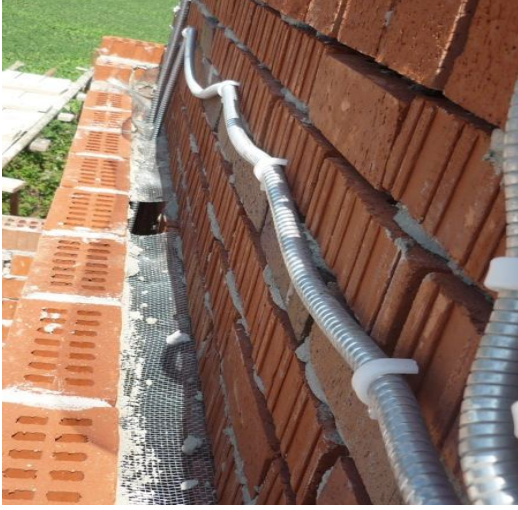
Şekil 4.7 : Hava tabakalı duvar içerisinden geçen tesisatlar
