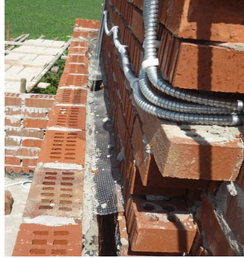
Şekil 4.7 : Hava tabakalı duvar içerisinden geçen tesisatlar
