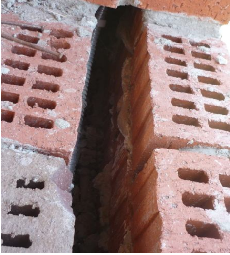
Şekil 4.1 : Örnek konutta kullanılan hava tabakalı tuğla duvar
