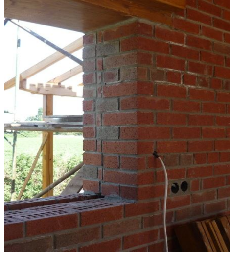
Şekil 4.1 : Örnek konutta kullanılan hava tabakalı tuğla duvar
