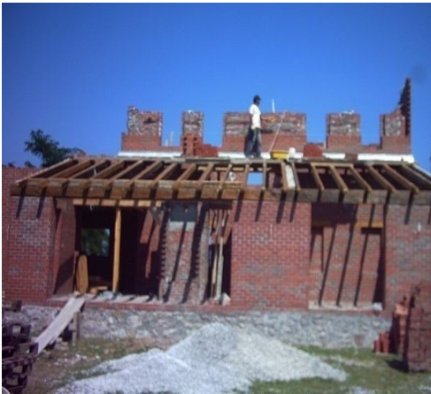
Şekil 4.8 : Güney cephedeki çatı – duvar birleşimi.
