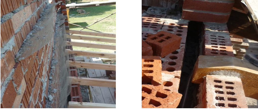
Şekil 4.10 : Giriş saçağının ahşap karkasları ile duvar birleşimi
