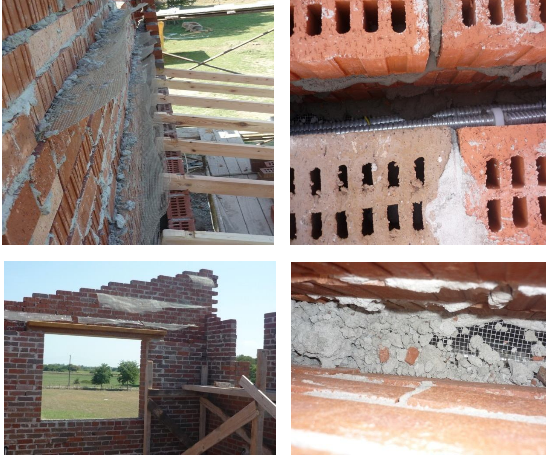
Şekil 4.4 : Örnek konutta duvar tabakalarını birbirine bağlayan kafes teller
