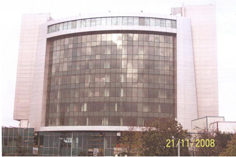
Şekil 5.2 : Kavacık Medikal Binası cephesi.
