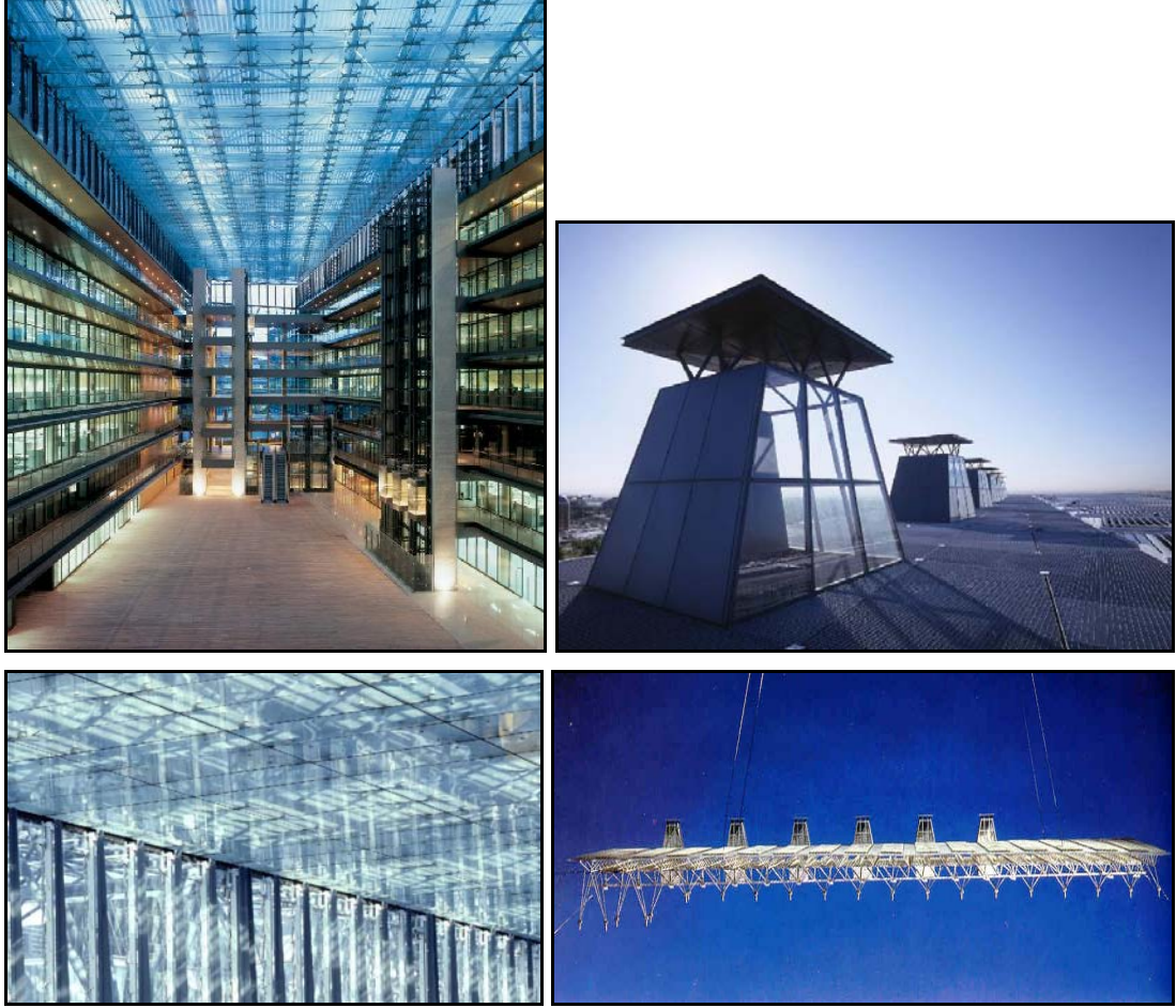
Şekil 2.28. Fotovoltaik paneller, cam güneş kıcı elemanlar ve hava bacalarının kombinasyonundan oluşan atrium çatı modeli [40-41]
