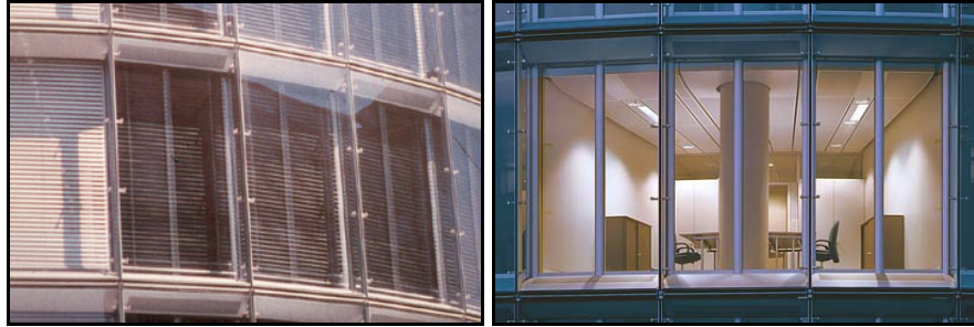
Şekil 2.17. RWE AG Binasının cephe detay görünüşü [34-35]
