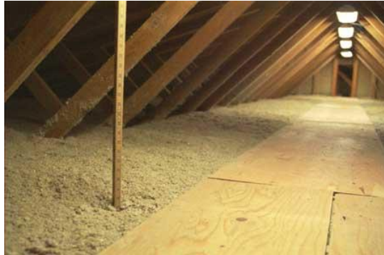
Şekil 4.4: Tavan Arasında Kullanılmış Serbest Selüloz Yalıtım
