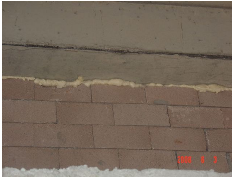
Şekil 5.66 Köpük Uygulaması
