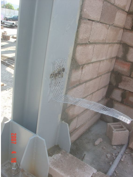
Şekil 5.30 Çelik Telin Kolona Kaynaklanması
