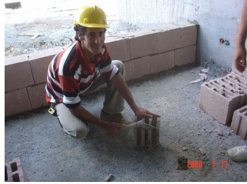
Şekil 5.50 Bimsbloğun Kesilmesi
