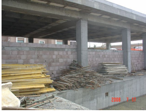
Şekil 5.41 Yatay Hatıl
