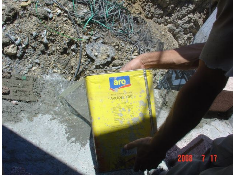
Şekil 5.51 Zeminin Islatılması
