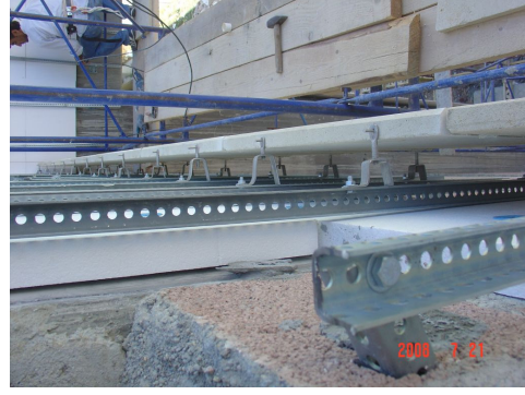
Şekil 5.38 Cephe Kaplama Detayı
