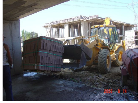
Şekil 5.2 CSB ile Taşınan Blokler
