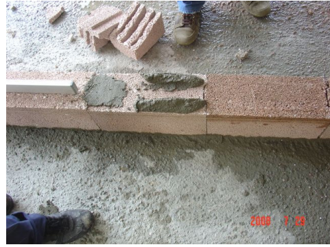
Şekil 5.71 Daire Ara Duvarlarının Harcı
