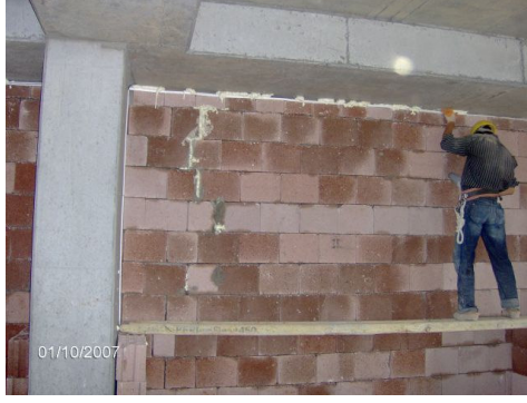
Şekil 5.75 Köpük Uygulaması
