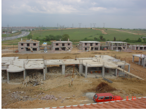
Şekil 5.17 Şantiye Genel Görünümü
