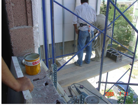
Şekil 5.37 Cephe Kaplama Ustaları
