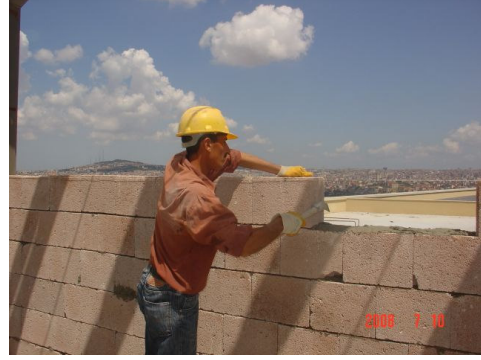
Şekil 5.74 Duvar Örülmesi
