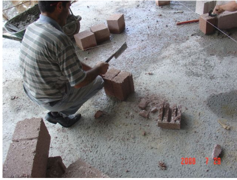
Şekil 5.70 Satır ile Bimsblok Kesimi
