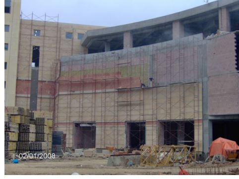
Şekil 5.76 Isı Yalıtım Uygulaması
