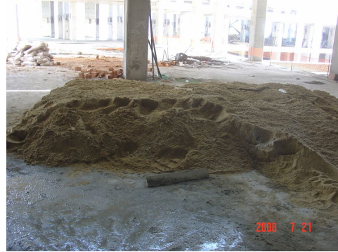
Şekil 5.6 Harç Yapımında Kullanılan Kum
