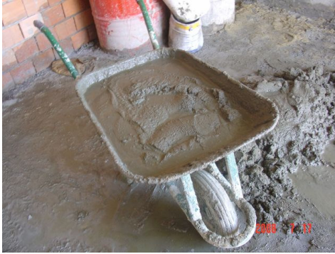
Şekil 5.5 Duvar Örmeye Kullanılan Harç
