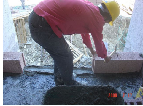
Şekil 5.52 Blokların Örülmesi
