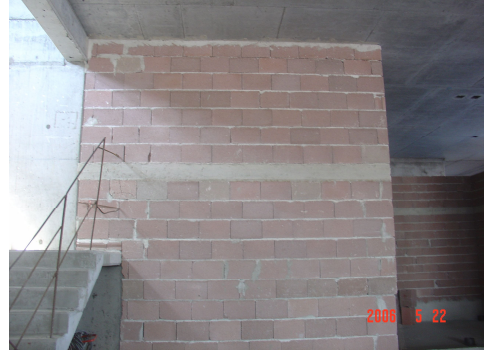
Şekil 5.25 Yatay Hatıl
