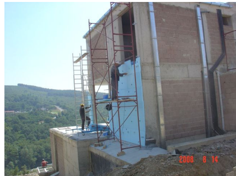
Şekil 5.62 Dış Duvar Üzerindeki Tesisat
