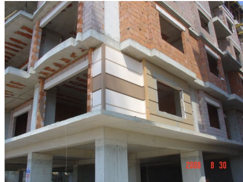
Şekil 5.54 Dış Cephe Görünümü
