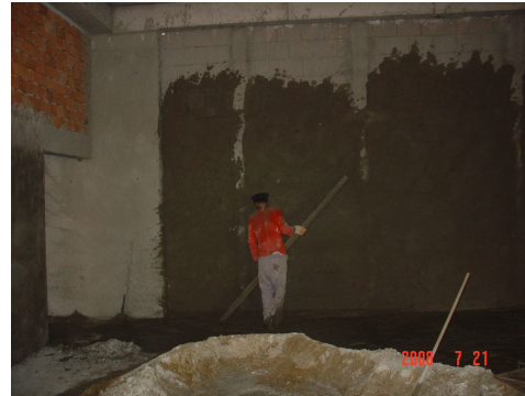
Şekil 5.36 Sıva Uygulaması
