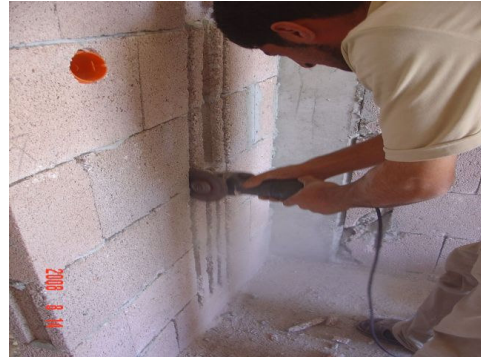
Şekil 5.58 Tesisat Kanalı Açılması
