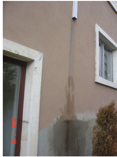
Şekil 5.16 Nemli Cephe
