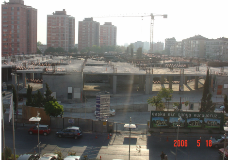
Şekil 5.2 Şantiyenin Genel Görünüşü
