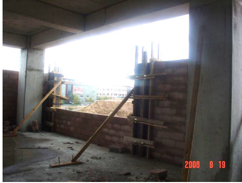
Şekil 5.84 Düşey Hatıllar
