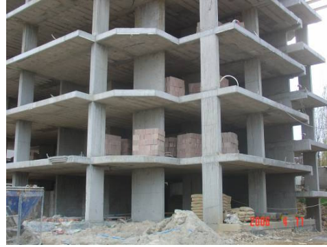
Şekil 5.13 Katlara Depolama
