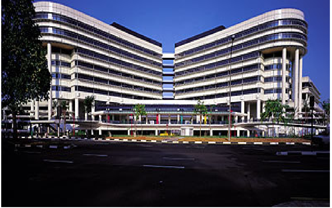
Şekil 3.5: Kandang Kerbau Hospital, Singapur, Ön Cephedeki Güneş Kırıcılar [4]
