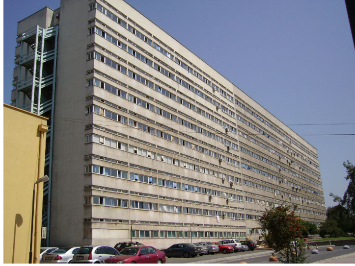
Şekil 5.1: Okmeydanı Eğitim Ve Araştırma Hastanesi Servisleri Güney-Doğu Cephesi
