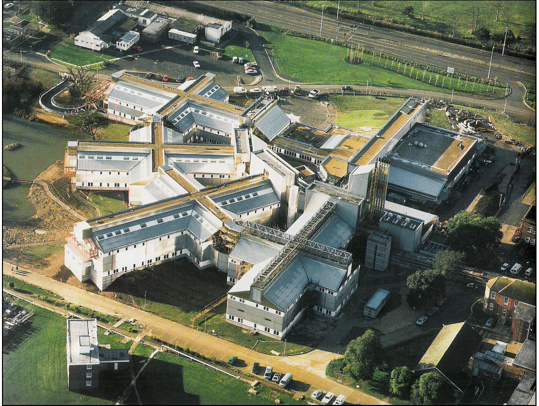
Şekil 3.2: St Mary's Hospital, Çatı Işıklıklarının Görünüşü, Newporr, Isle Of Wight, UK (Monk, T., 2004)
