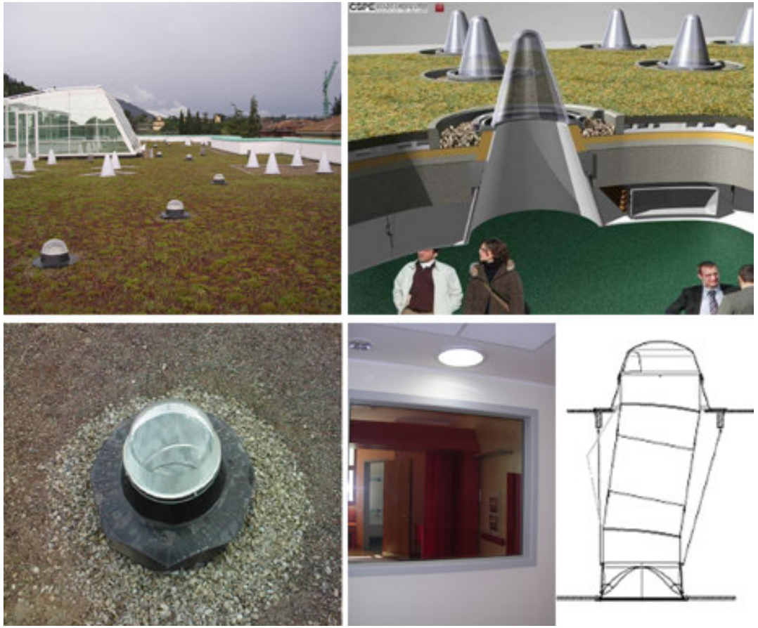
Şekil 3.3: New Meyer Hospital'ın Çatısında Bulunan Işık Tüpleri, Floransa, İtalya [3]
