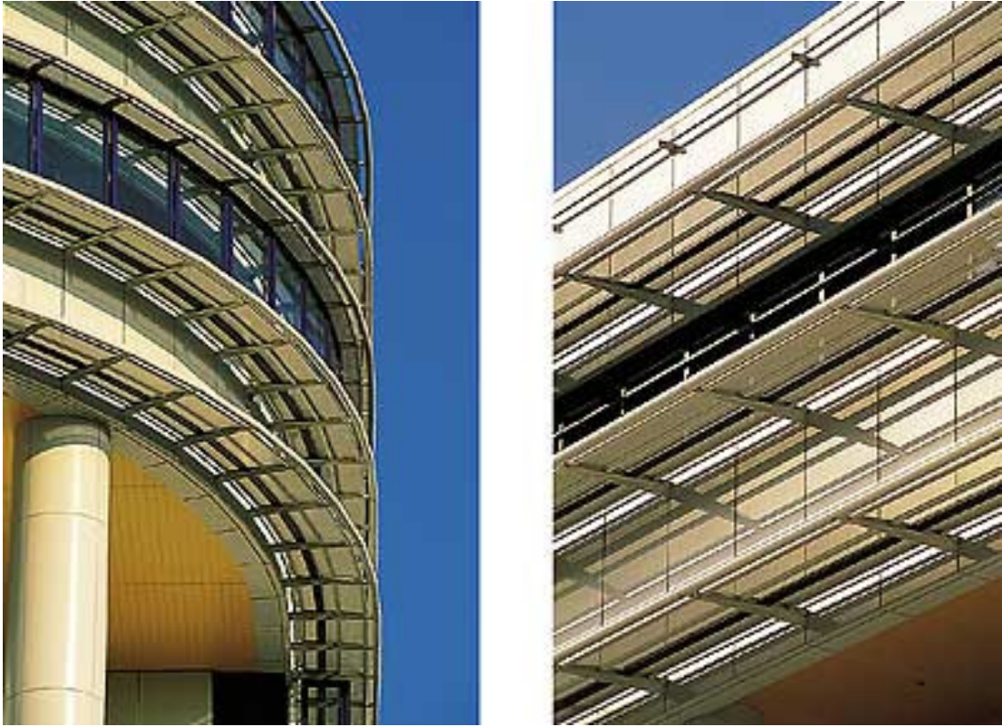
Şekil 3.4: Kandang Kerbau Hospital, Singapur, Hasta Yatak Odalarına Gelen Direkt Güneş Işığını Engelleyen Güneş Kırıcılar [4]
