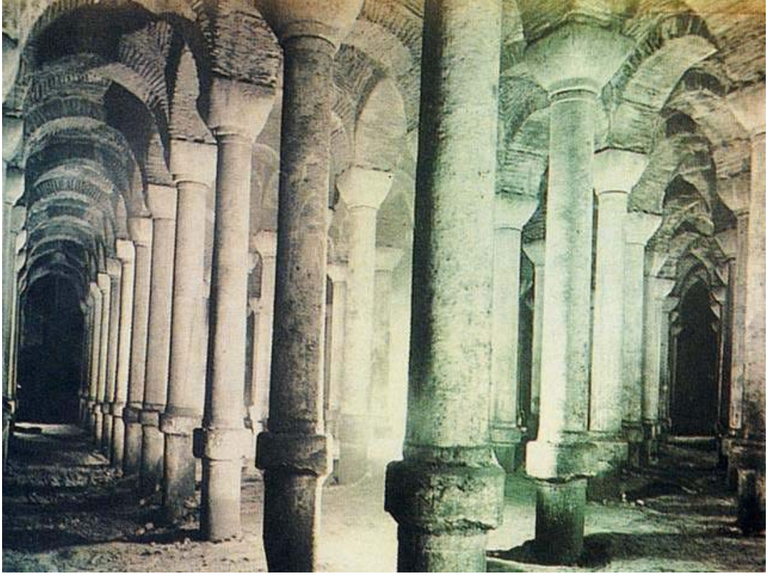
Şekil 1.7: Onarımlar sırasında sarnıç içindeki suyun boşaltılarak dipteki balçık tabakasının temizlenmesi.
