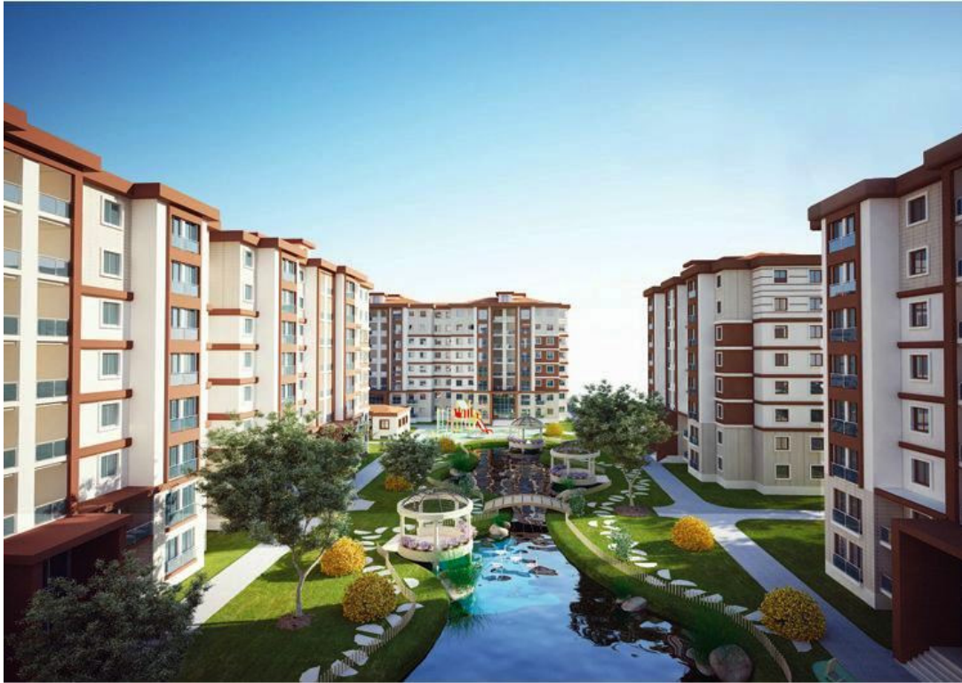
Şekil 5.2 : Çalışması yapılacak olan toplu konut sitesi, blokların site içinden görünümü [70].
