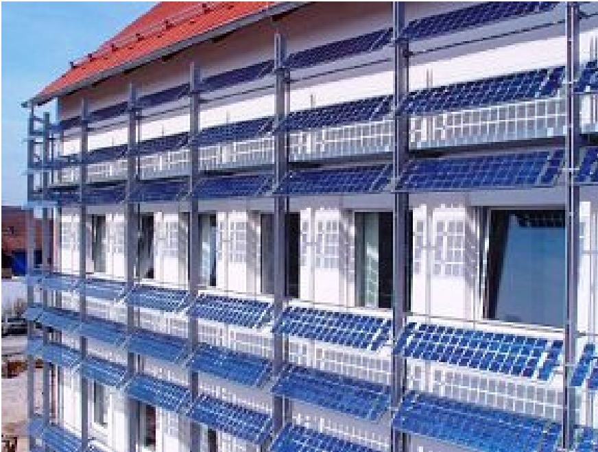
Şekil 4.10 : Pv panellerin güneş kırıcı olarak kullanımı [68].
