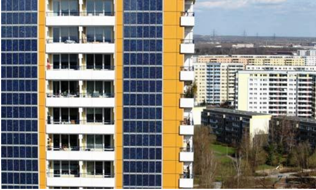
Şekil 4.9 : Pv panellerin bir apartman cephesinde kullanımı [67].
