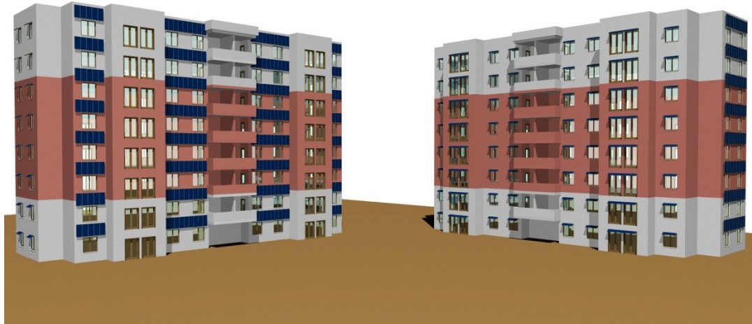
Şekil 5.14 : Sitede uygulama çalışması için seçilen bloklar ve pv yerleşimleri.
