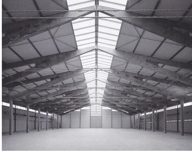
Şekil 4.13 : Tavan aydınlatması ve göz hizasından yukarıda küçük pencereler (clerestory), (Adam, J., 2004).
