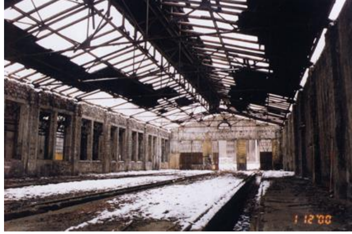
Şekil 5.10 : Çatının çelik konstrüksiyonu, (Uygur Mimarlık, Fotoğraf arşivi).
