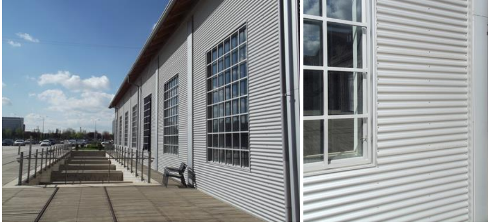
Şekil 5.19 : Galeria 4 Cephesinin oluklu metal sac kaplaması, (Sezer, S., 2013).
