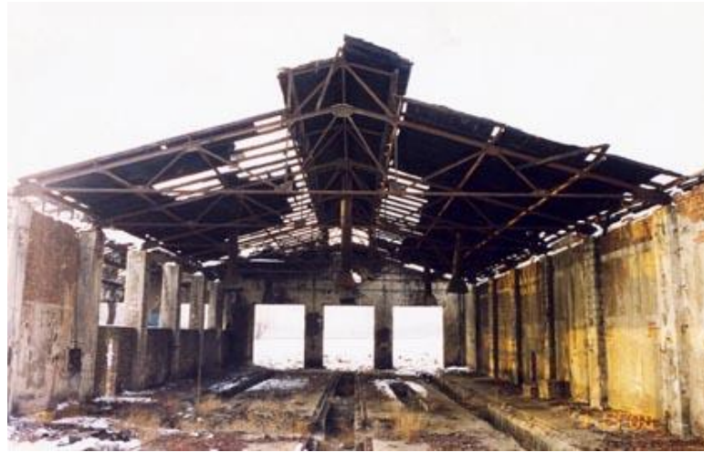
Şekil 5.11 : Çelik makasları taşıyan betonarme kolonlar – (Uygur Mimarlık, Fotoğraf arşivi).
