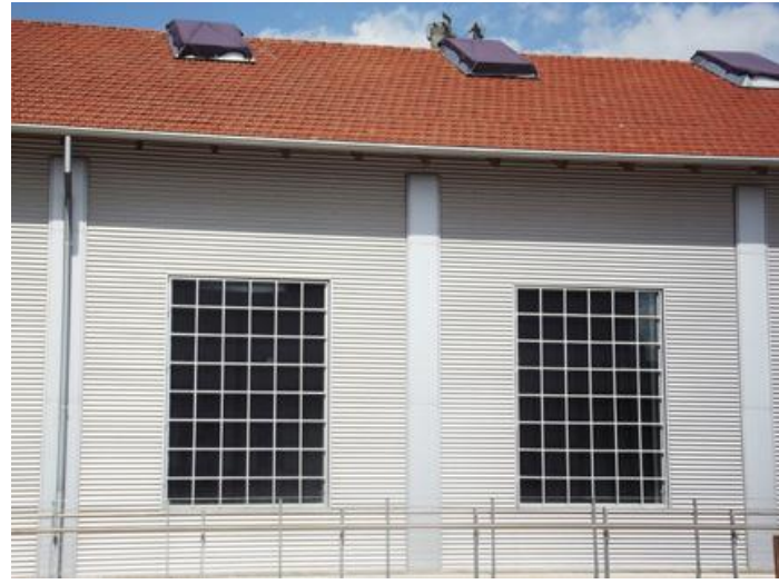
Şekil 5.35 : Siyah örtülerle kapatılmış çatı ve pencere açıklıkları, (Sezer, S., 2013).
