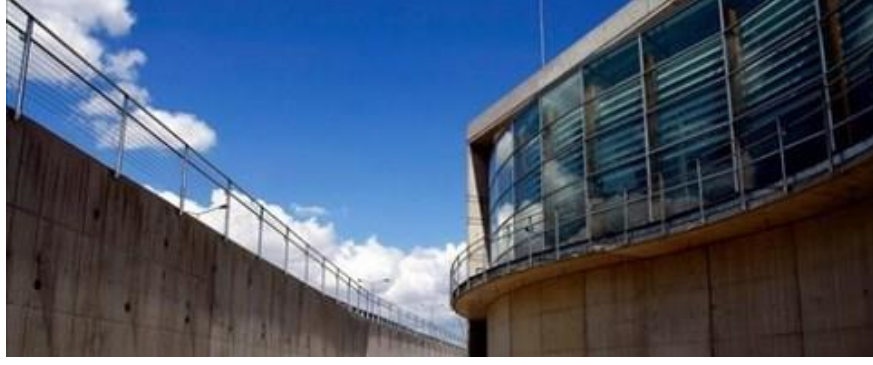
Şekil 5.21 : Ek binanın yapıyı sarmaladığı arka cam cephe, (url-21).
