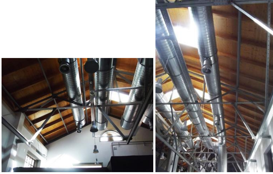
Şekil 5.49 : Galeria 4'ün çatı ışıklıkları ve açıkta bırakılmış olan strüktürel sistem, (Sezer, S., 2013).
