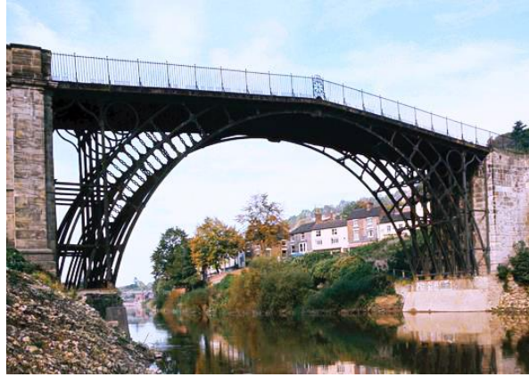
Şekil 3.1 : Coalbrookdale köprüsü, 1775-1779, (Url-1).
