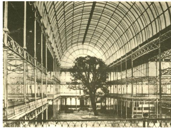
Şekil 3.4 : Crystal Palace, X harfi oluşturan dövme demir çubuklar, (Roth, L. M., 2000).
