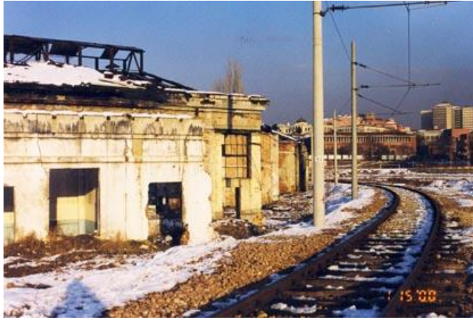
Şekil 5.9 : Yarıyı yıkılmış diğér iki birim ve tren yolu hattı, (Uygur Mimarlık, Fotoğraf arşivi).
