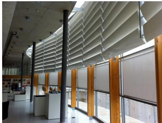
Şekil 5.28 : Güneş kırıcı elemanlar, (Url-30).
