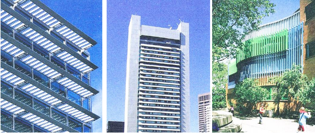
Şekil 4.21 : Bina mimarisine entegre edilmiş olan farklı güneşlik uygulamaları, (IESNA-2011).
