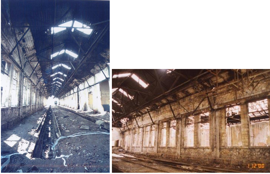
Şekil 5.12 : İkinci dönem yapısının çatı açıklıkları ve geniş pencereler, (Uygur Mimarlık, Fotoğraf arşivi).
