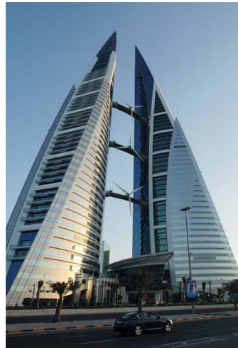
Şekil 3.17 : Bahrain Dünya Ticaret Merkezi binası rüzgar türbinleri.
