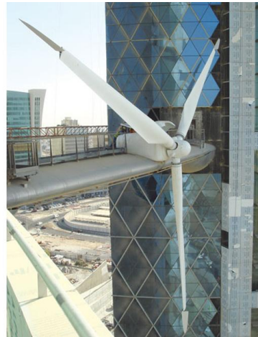
Şekil 3.17 : Bahrain Dünya Ticaret Merkezi binası rüzgar türbinleri.
