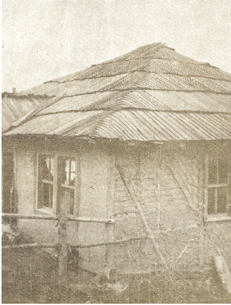
Şekil 6.14. İnce tahta kaplama çatı örtüsü [40].
