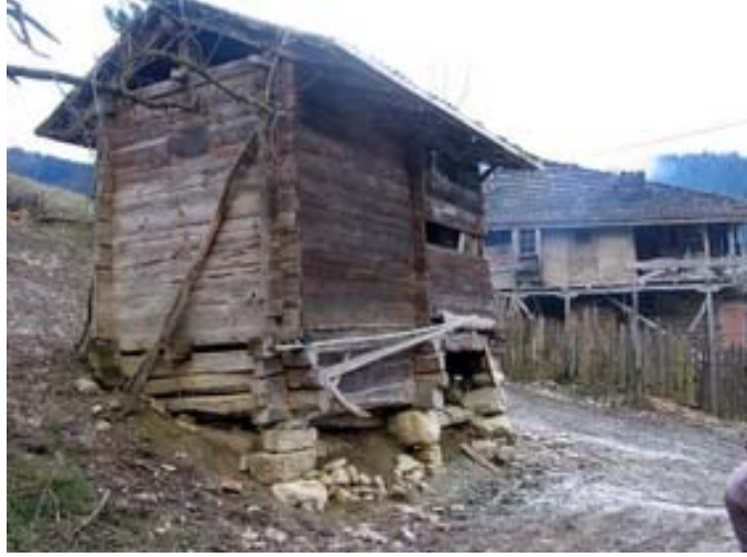
Şekil 2.1. Yığma ahşap (kütük) ev, Bartın [10].
