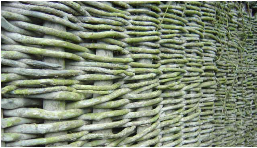
Şekil 6.8. Giresun ilinde ince dal örgü kaplama detayı.
