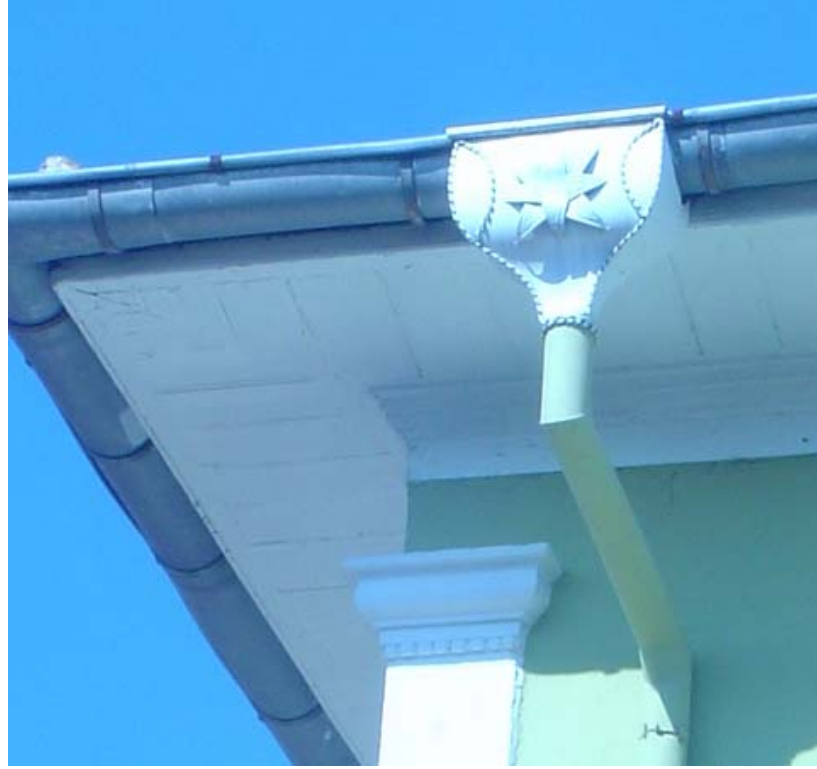
Şekil 6.15. Geleneksel ahşap evlerde çatı-saçak-yağmur oluğu, Giresun.
