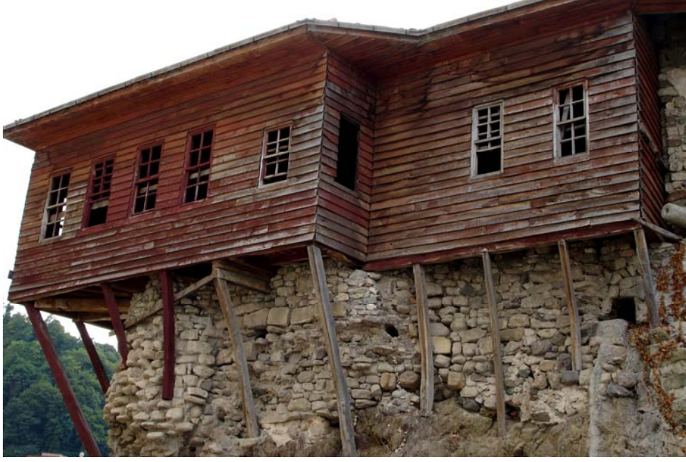
Şekil 6.2. Kagir taş temeller üstüne yapılmış bir ev, Bolaman [41].
