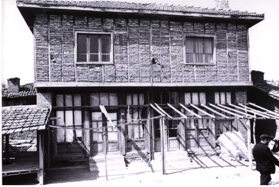
Şekil 2.3. Taşıyıcı sisteminde payanda bulunmayan yapı, Kuzey Anadolu.
