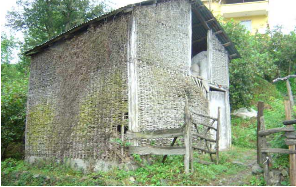
Şekil 6.7. Giresun ilinde ince dal örgü kaplama yapısı.
