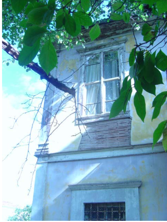
Şekil 2.6. Yatay çıtalarla güçlendirilmiş ahşap yapı, Giresun.
