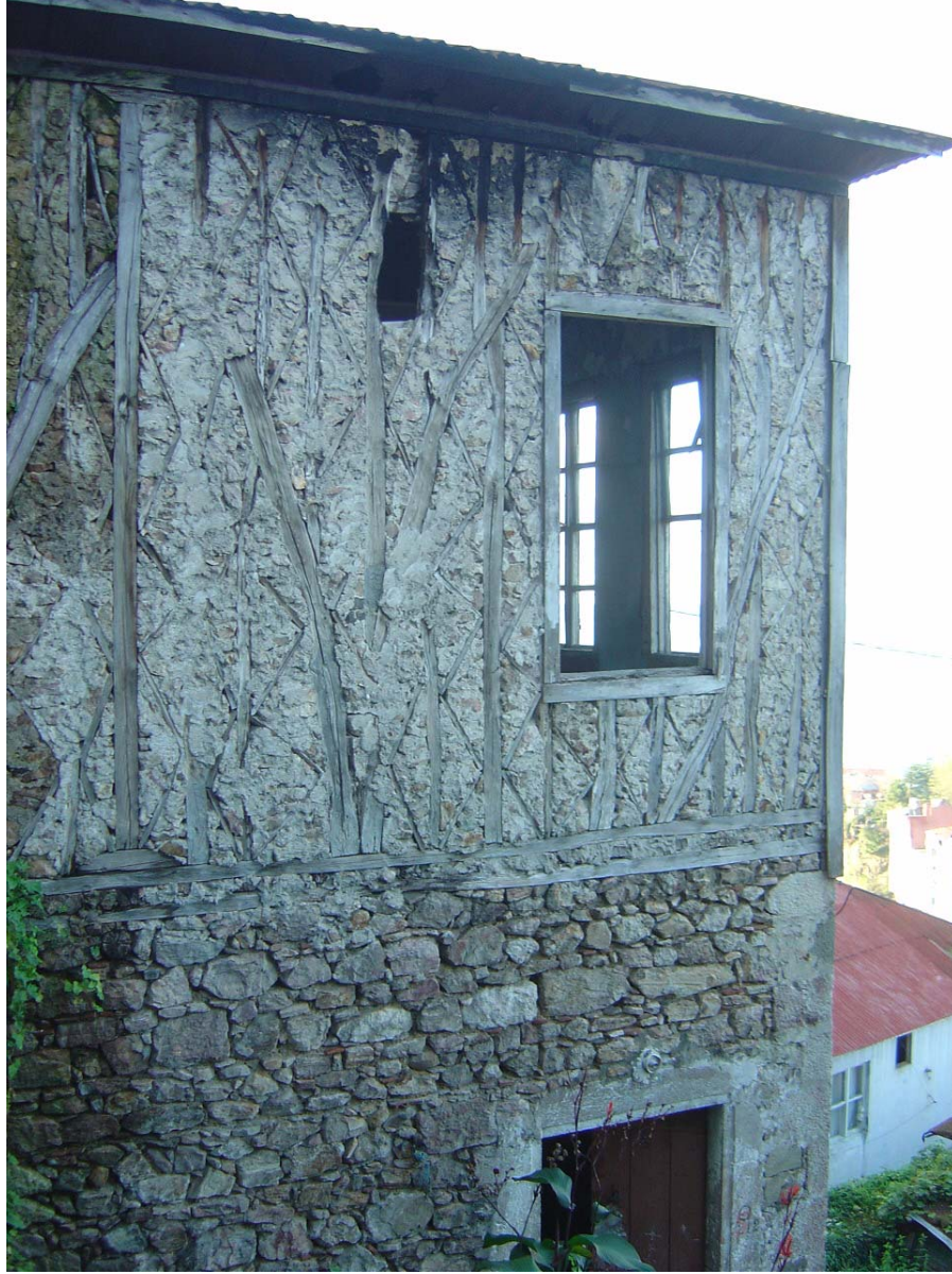
Şekil 8.2. Giresun Tirebolu ilçesinden muskalı dolma ahşap iskelet sistem örneği.
