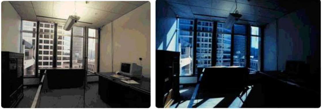
Şekil 2.23: Sırasıyla bulutlu ve güneşli gün için elektrokromik camların iç mekan görünüşleri (Tavil, 2007).
