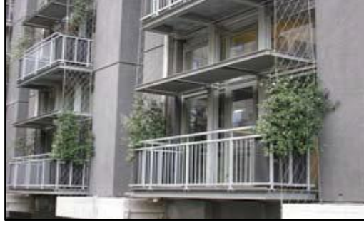
Şekil 2.41: Doğu ve batı cephelerinde bitkilendirme (Council House 2, Avustralya).
