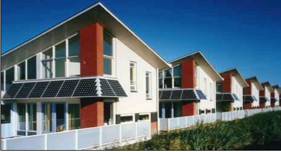
Şekil 2.49: Gölge elemanı olarak PV uygulaması, Hollanda.
