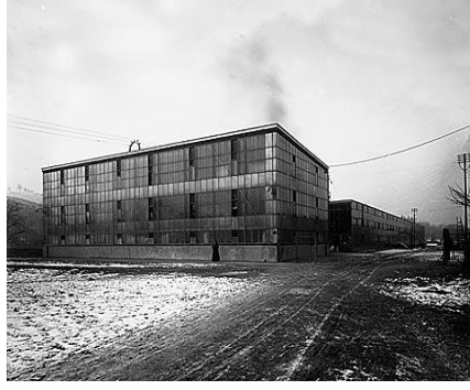
Şekil 2.2 : Steiff Factory, Almanya, Giengen [9].
