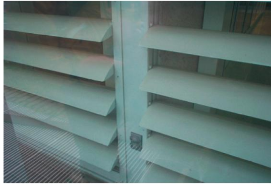
Şekil 2.24 : Beyaz renkli güneş kırıcı lamellerin üzerinde biriken toz- Occidental Chemical Center [37].
