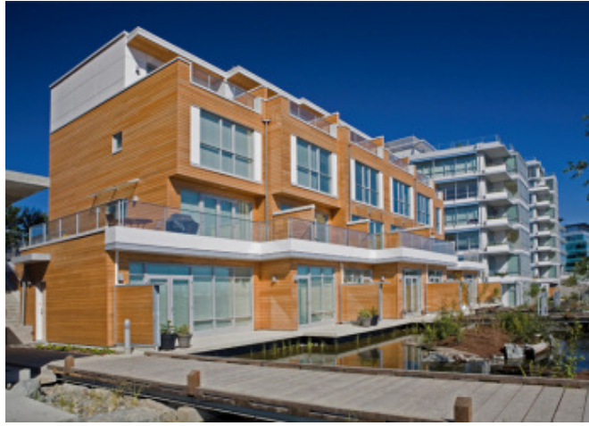
Şekil 2.2 : Dockside Green binası (Url-6)
