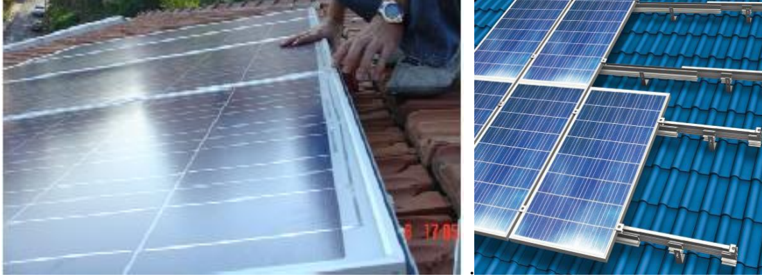
Şekil 3.22 : Çatı örtüsü üzerine ek bir strüktür ile PV kullanımı [47]
