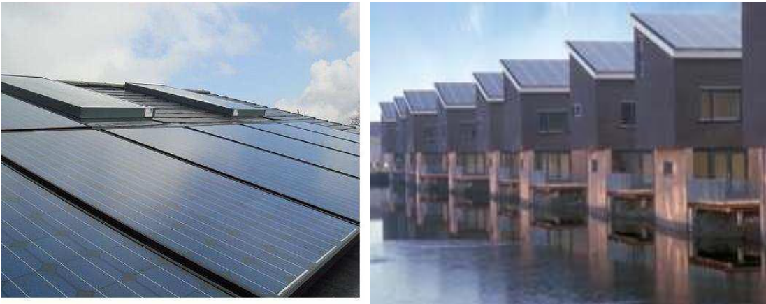
Şekil 3.23 : Çatı örtüsü ile bütünleştirilmiş PV kullanımı [47]
