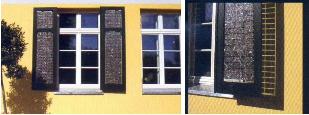
Şekil 3.38 : PV’lerin güneş kepenklerinde kullanımı, Almanya [54]
