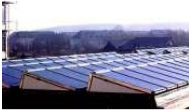
Şekil 3.25 : Şet çatıda PV kullanımı [49]
