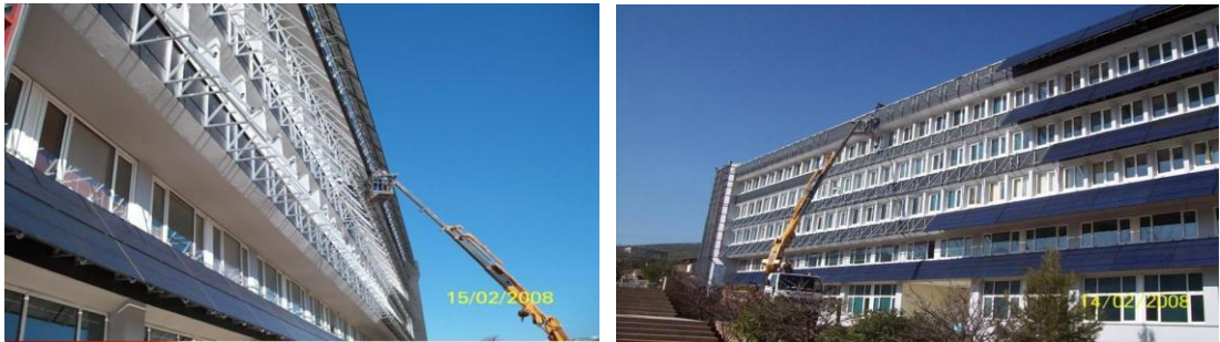
Şekil 3.34 : PV'lerin sabit gölgeleme elemanı olarak kullanımı, Muğla [52]
