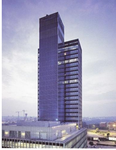
Şekil 3.29 : PV'lerin perde duvarda kullanımı, İngiltere [34]
