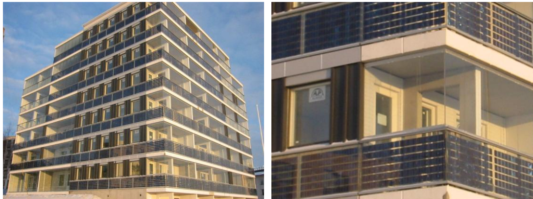
Şekil 3.40 : PV’lerin bina korkuluğunda kullanılması, Finlandiya [55]
