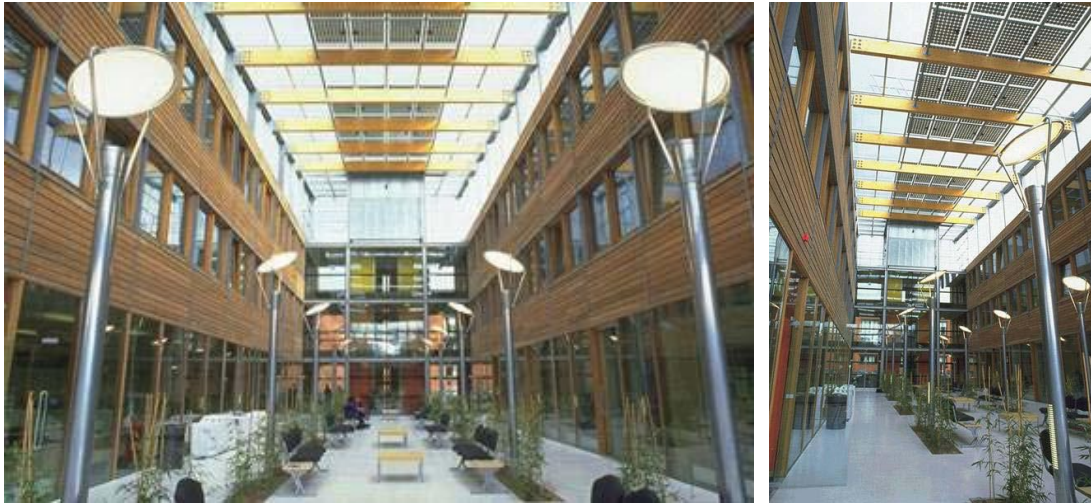
Şekil 3.27 : Atriumda PV kullanımı, İngiltere [50]
