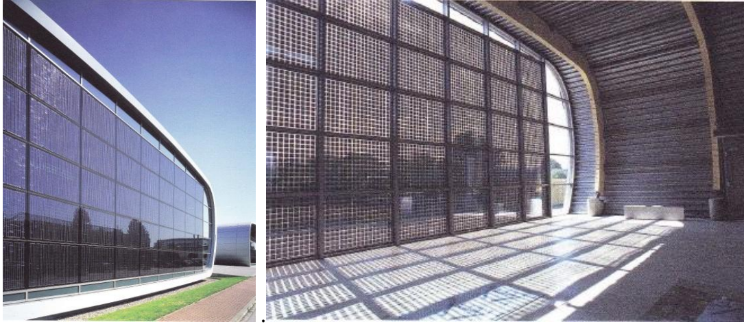
Şekil 3.31 : Strüktürel silikonlu PV giydirmce cephe sistem detayı [34]
