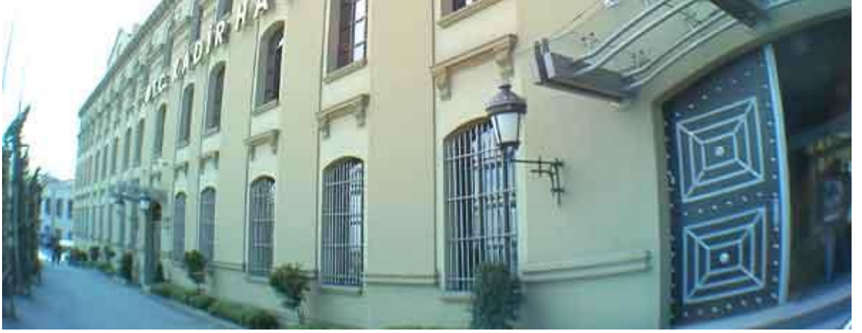
Şekil 5.20. Kadir Has Üniversitesi'nin Haliç'e bakan cephesi (Cibali Merkez Kampüsü, 2003)
