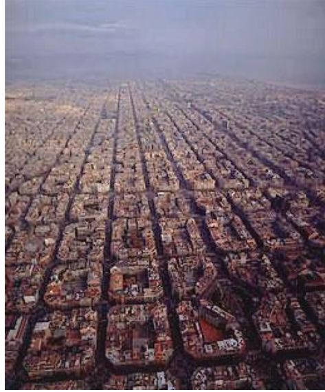
Şekil 3.4 : Barselona kapalı şehir blokları genel görünüm (Url-2).
