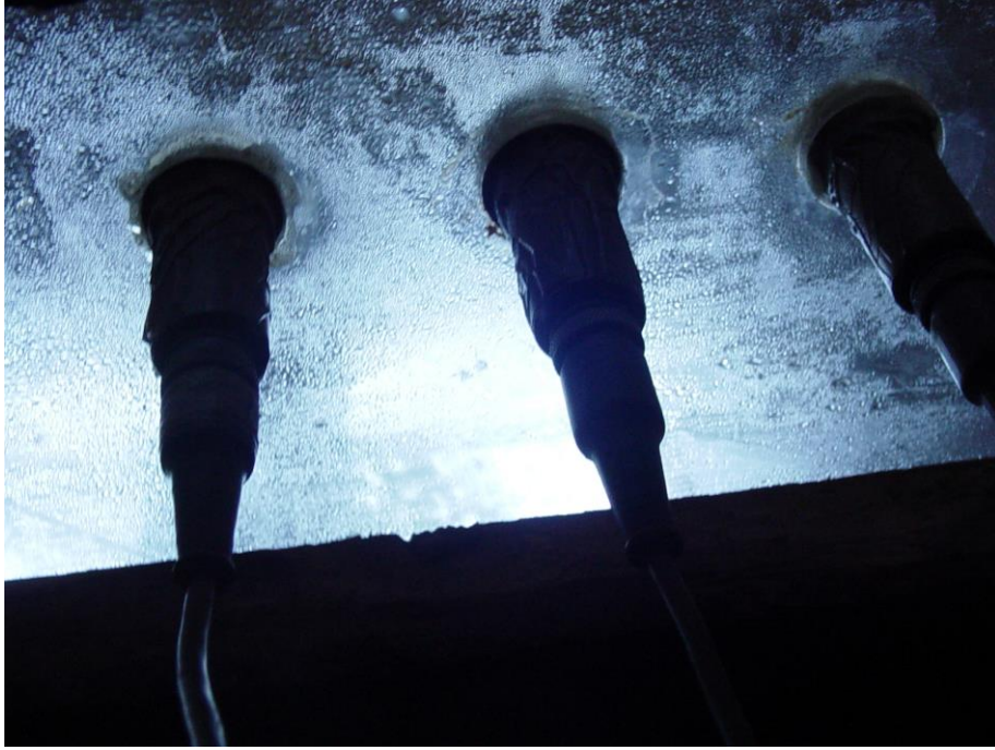
Şekil 3.6 Kanallın Alt Kısımından Pleksiglasa Monte Edilen Basınç Ölçerlerin Alttan Görünüşü
