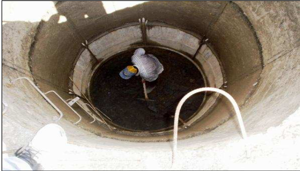
Şekil 1.7 : Keson (geniş çaplı) kuyu.
