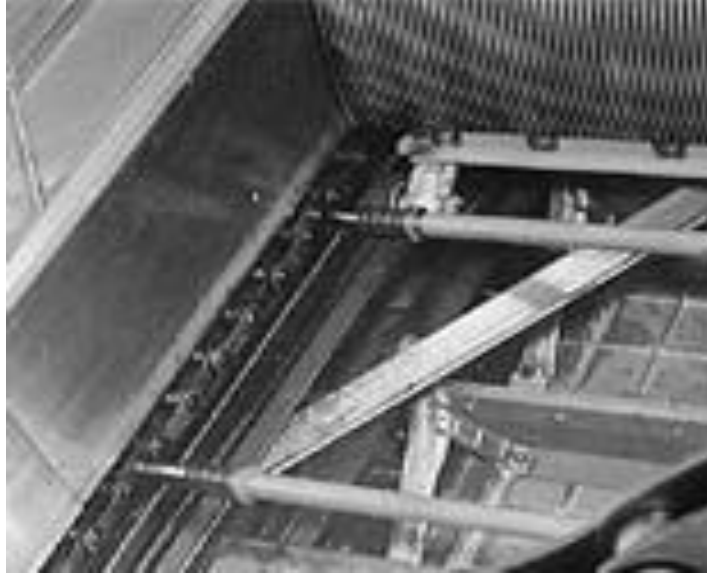
Şekil 2.5. Yürüyen merdivende tahrik zinciri, tekerlek aksı ve basamak
