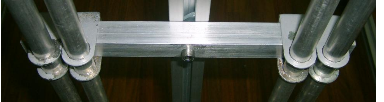
Şekil 7.31 : Boruların İskelete Sabitlenmesi
