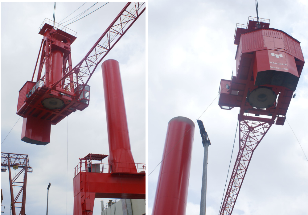
Şekil 1.5: JIB krenin montajı
