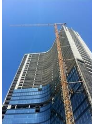
Şekil 6.2: Risk Değerlendirmesinin yapıldığı kule vinç.
