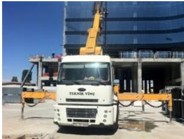
Şekil 6.3: Risk Değerlendirmesinin yapıldığı mobil vinç.
