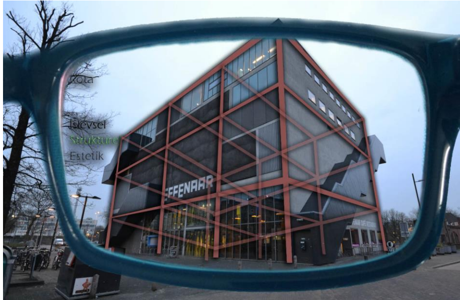
Şekil 5.44 : EFFENAAR yapısının strüktürel içerik sunumu.
