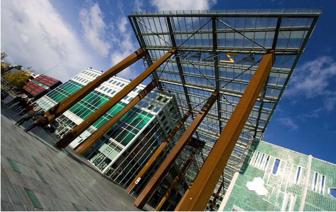
Şekil 5.15 : 18 Septemberplein alanından Piazza Center'ın görünümü.
