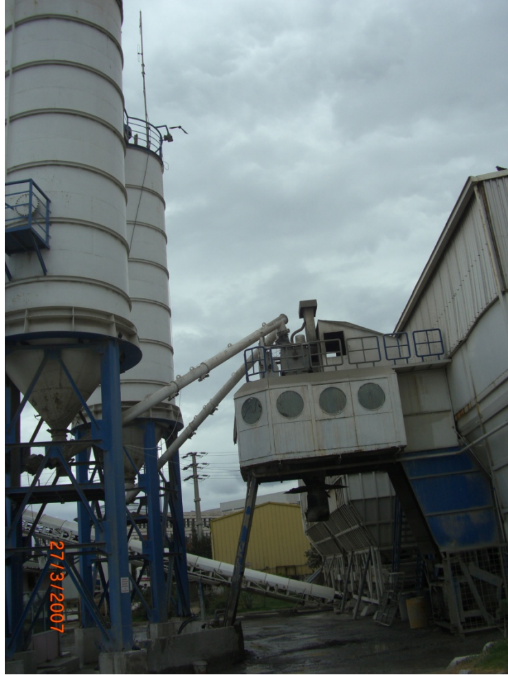
Şekil A.1: Hazır Beton Santrali ve Siloları
