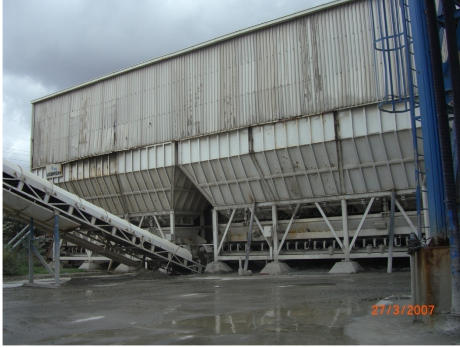
Şekil A.2: Agregat Bunkerleri
