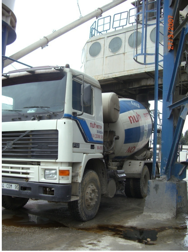
Şekil A.4: Santralden Transmiksere Beton Yüklenmesi
