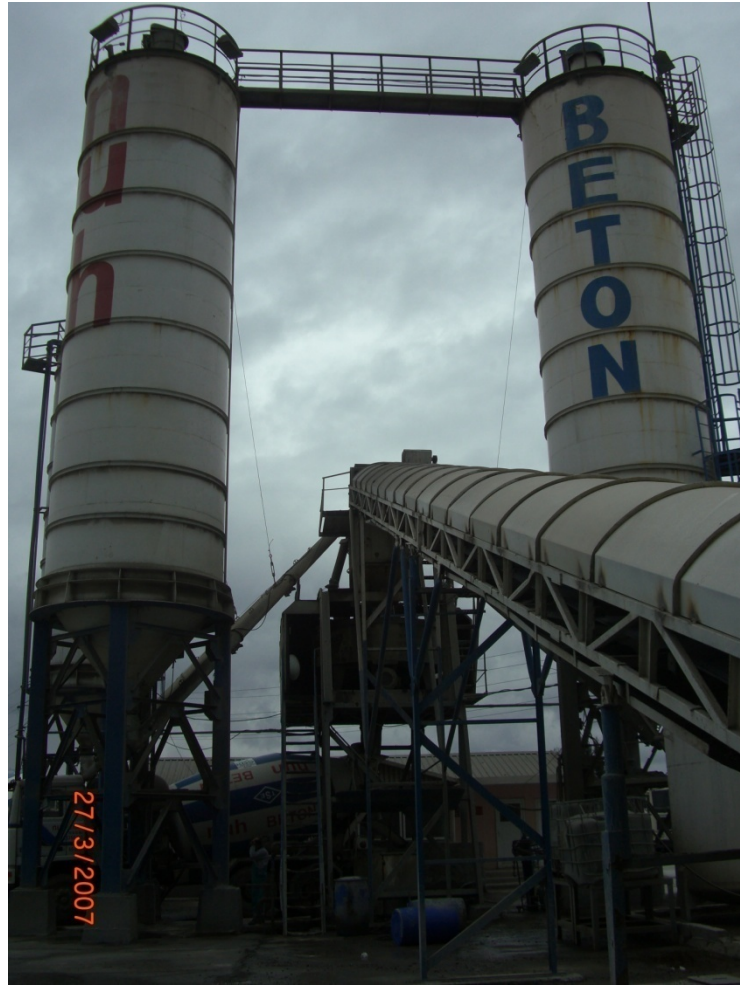
Şekil A.3: Bunker - Santral Arası Bant ve Silolar
