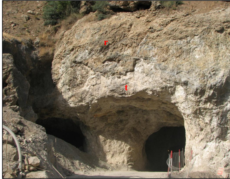
Şekil 3.11 : Tahtalıkuyu Bölgesi cevherleşmelerine ait galeri girişinde riyolit-tüf kontağının görünümü.
