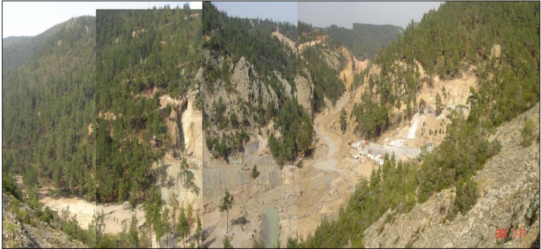
Şekil 1.2 : İnceleme alanının genel görünümü.
