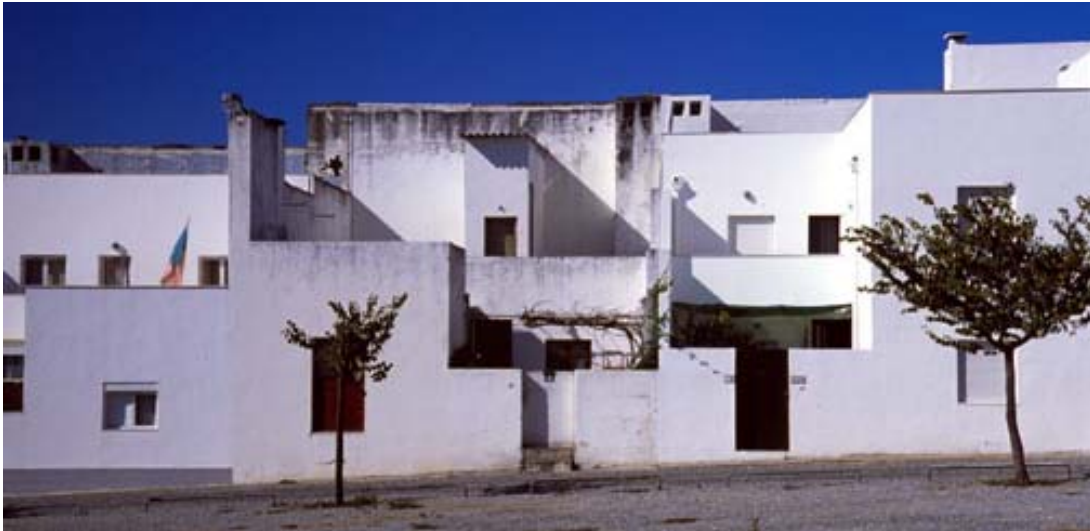
Şekil 2.5 : Malqueira konutları – Alvor a Siza (Url-2).
