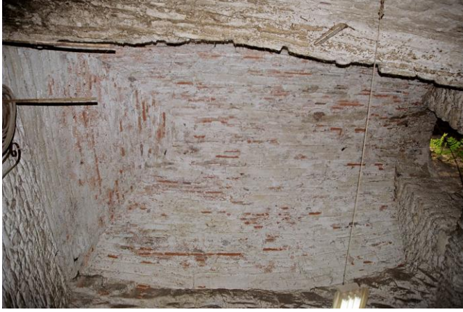
Şekil 2.22: Bema üzerindeki sonradan yapılmış aynalı tonoz ve sağda pencere (2005).
