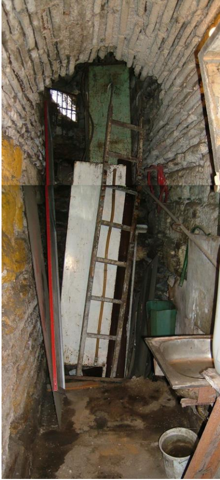
Şekil 2.26: Bema güney duvarındaki geçit (2005).
