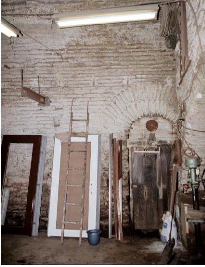
Şekil 2.24: Bema güney duvarındaki geçiş kapısı (2005).
