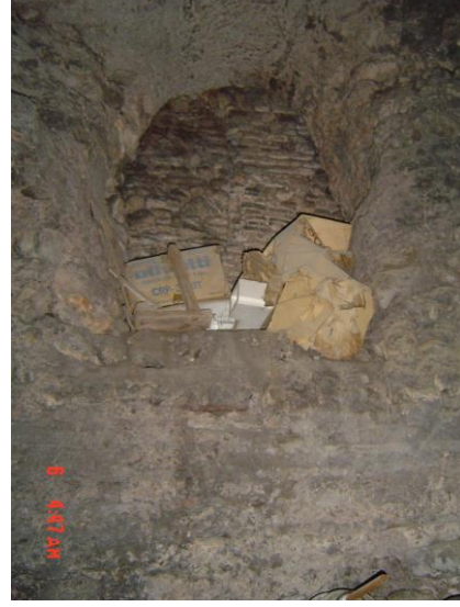
Şekil 2.43: Bema yan odası kuzey duvarındaki içi örülmüş pencere veya niş (2005).
