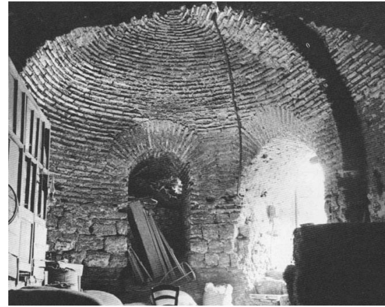
Şekil 2.19: Kapı atölyesinden önceki durum, giriş ve apsis (1936).
