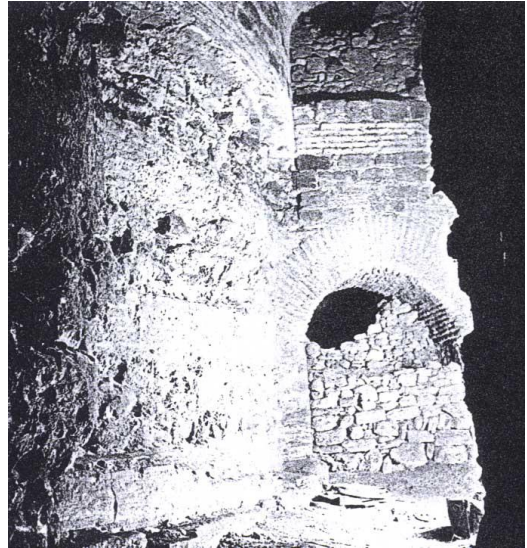
Şekil 2.50: Bema yan odası, çevre koridorunun başlangıcındaki içi örülerek iptal edilmiş kemerli kapı (1936). Photo Artamonoff, Dumbarton Oaks Field Committee, RA251b.
