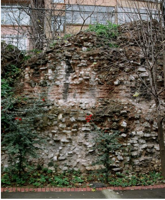
Şekil 2.57 Mokios sarnıcı güney duvarı
