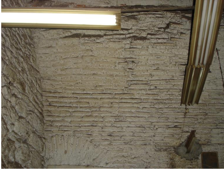
Şekil 2.29: Bemanın kuzey tarafındaki tonozun tamir izleri (2005).
