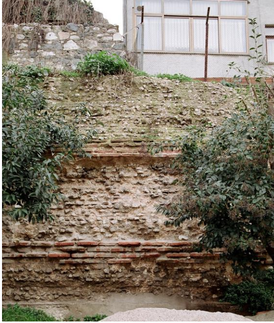
řekil 2.55 Aetius sarnıcı kuzeydođu duvarı
