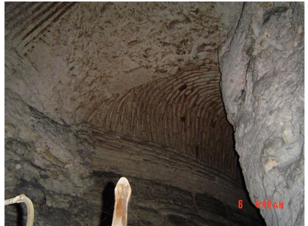
Şekil 2.47: Bema yan odasında çevre koridorunun başladığı noktada kırılmış kemer tonoz üzerindeki dikkat çekici yüzey bozuklukları ve kırılma izleri (2005).
