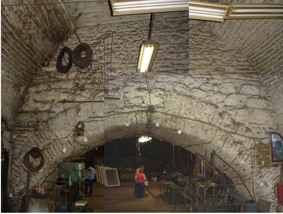
Şekil 2.30: Bema tarafından kemer örgüsünde bozulmalar (2005).
