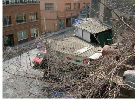
Şekil 2.6: Hagios Menas Kilisesi'nin avlusundan oto servisi ek yapıları.
