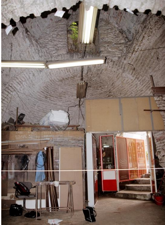
Şekil 2.18: İç mekandan kapı atölyesi girişi, apsis ve bema (2005).
