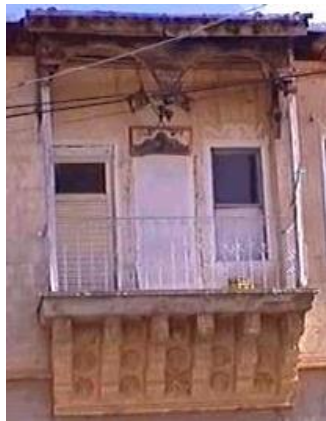
Şekil 6.11 Taş konsollu, ahşap sütunlu bir açık çıkma örneği ve taş konsollu bir çıkma örneği
