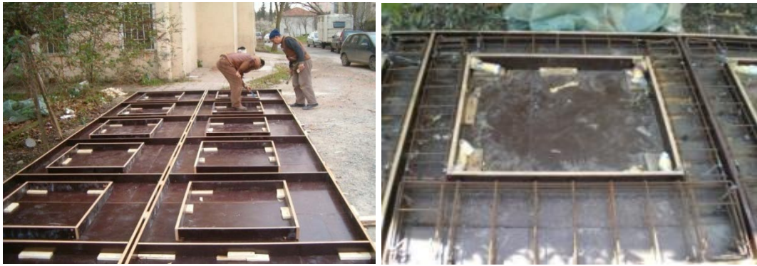
Şekil 2.4 : Numune Kalıplarının ve donatıları kalıp içine yerleştirilmesi.
