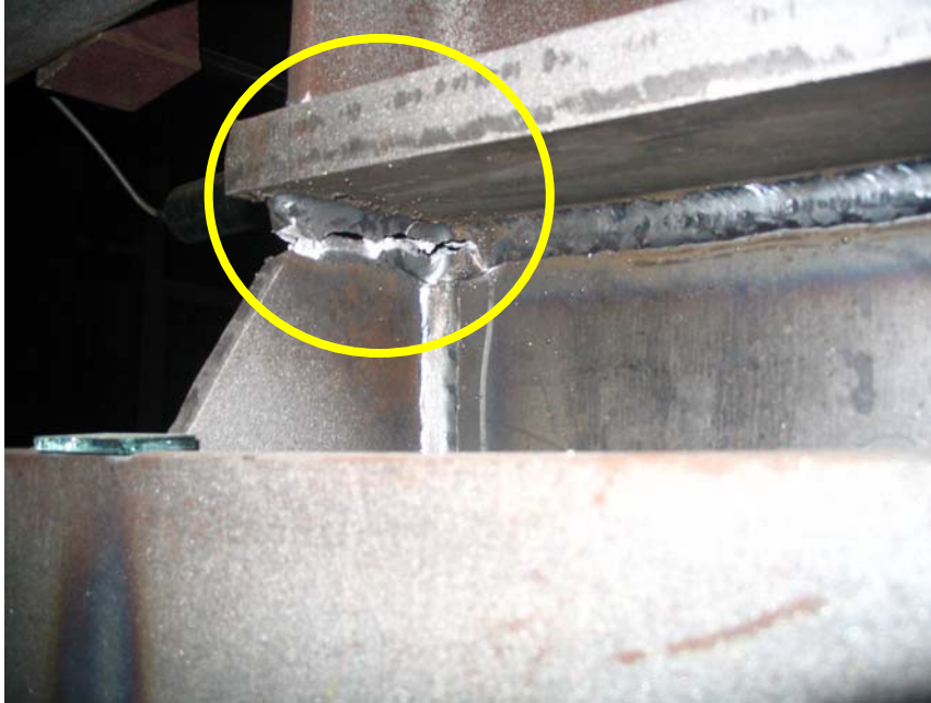
Şekil 5.56 : Kaynak altından kopmuş iç takviye levha sistemi.
