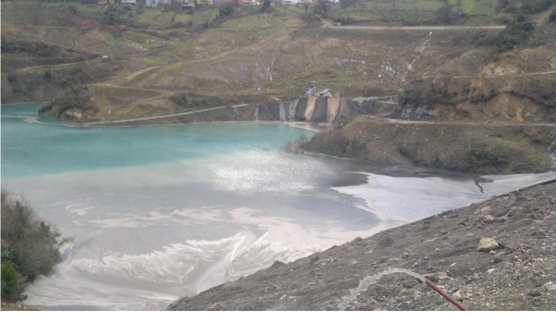
Şekil 4.4 : Çatalağzı termik santrali kül barajı resimleri-II.
