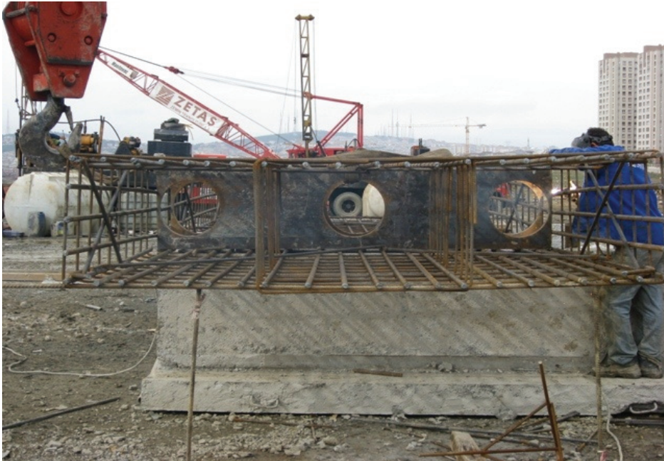
Şekil 6.5 : Yükleme düzeneğinin donatı kafesine montajı
