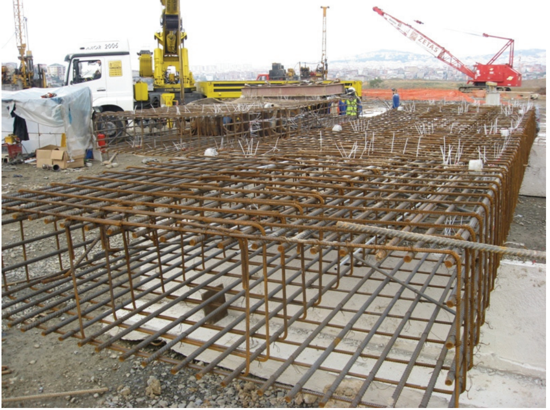
Şekil 4.10 : Donatı kafesinin hazırlanması (ZETAŞ katalog, 2011)
