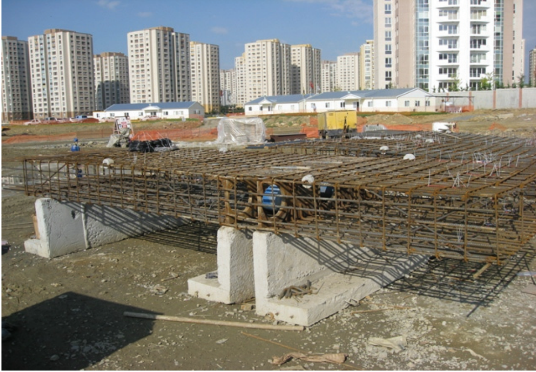
Şekil 6.7 : Yükleme düzeneğinin donatı kafesine montajı
