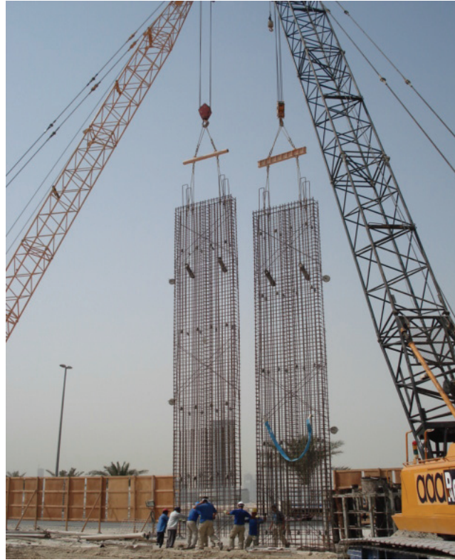
Şekil 4.11 : Donatı kafesinin indirilmesi (ZETAŞ katalog, 2011)
