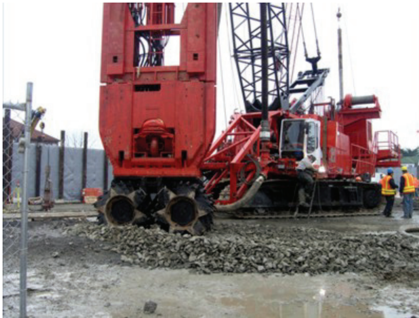
Şekil 4.2 : Hidrofreze (cutter), (projects.soundtransit.org)
