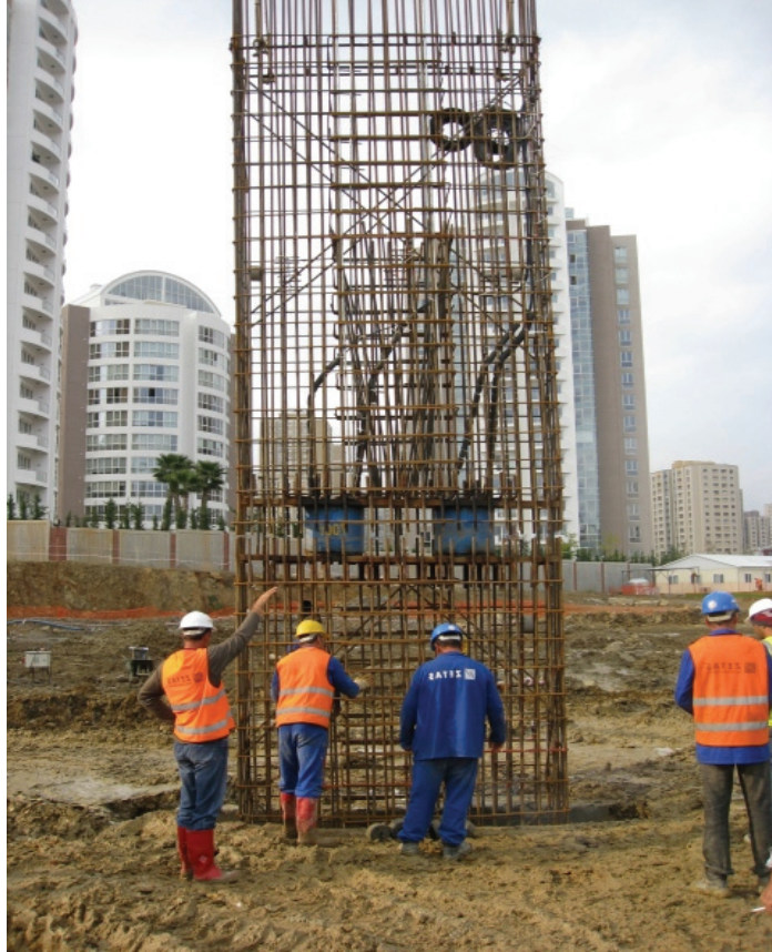
Şekil 6.8 : Donatı kafesi ve yükleme düzeneğinin kuyuya montajı
