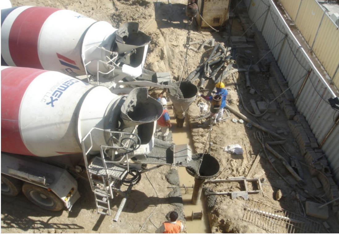
Şekil 4.12 : Betonlama (ZETAŞ katalog, 2011)
