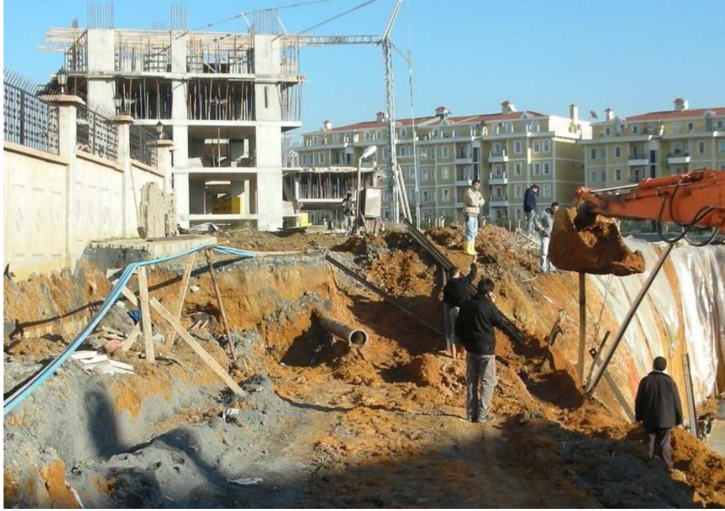
Şekil 5.5 : Kırılan su borusu.
