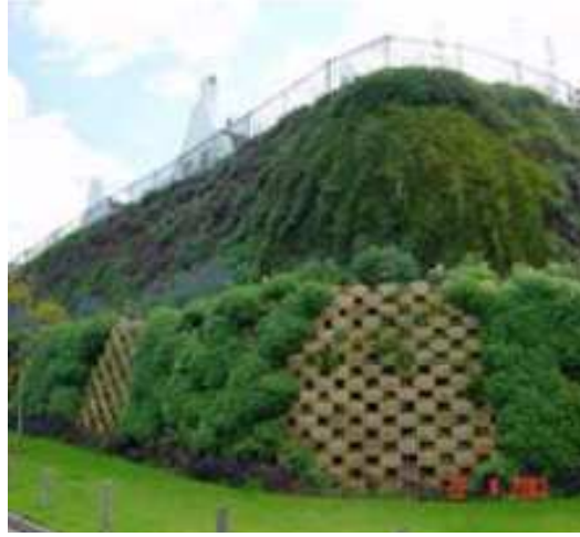
Şekil 4.11 : Bitkilendirme ve yapısal elemanlar ile stabilitesi sağlanmış bir duvar (Pupescu ve Sasahara, 2009).
