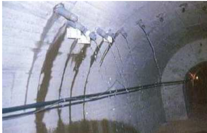
c. Drenaj tüneli ve yatay delgiler
