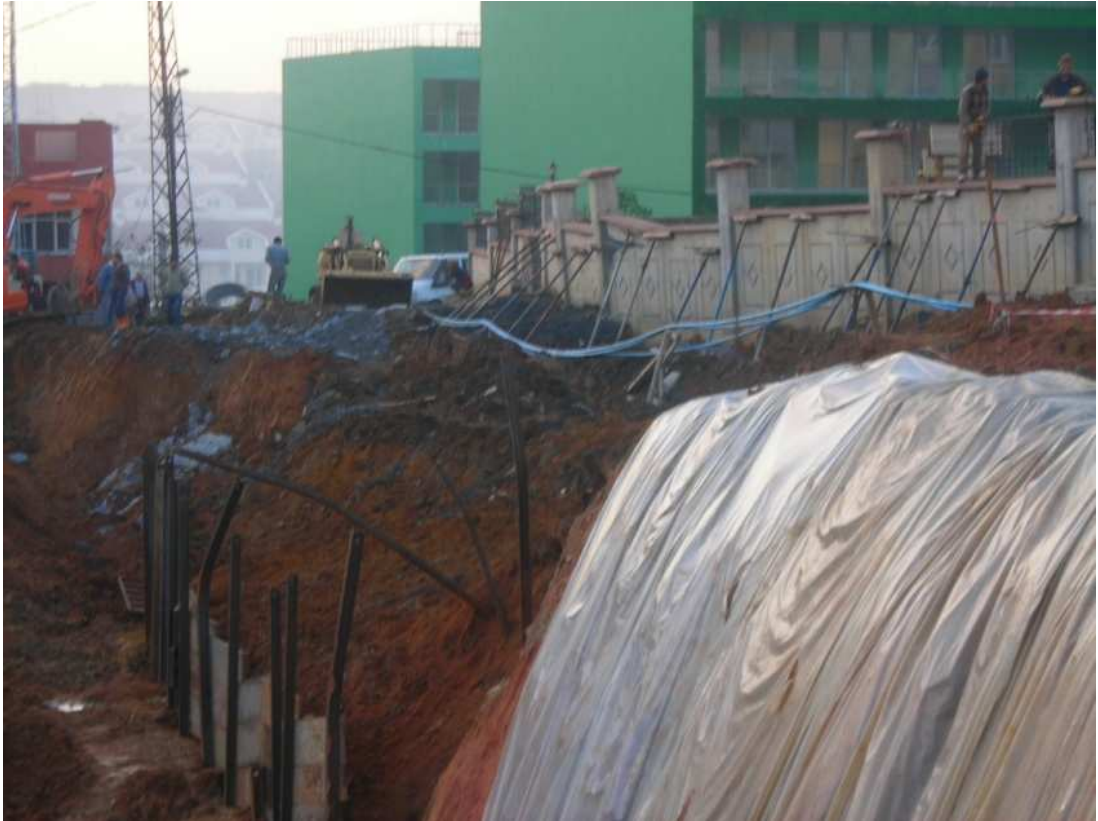
Şekil 5.1 : Desteksiz kazıda karşılaşılan şev kayması.
