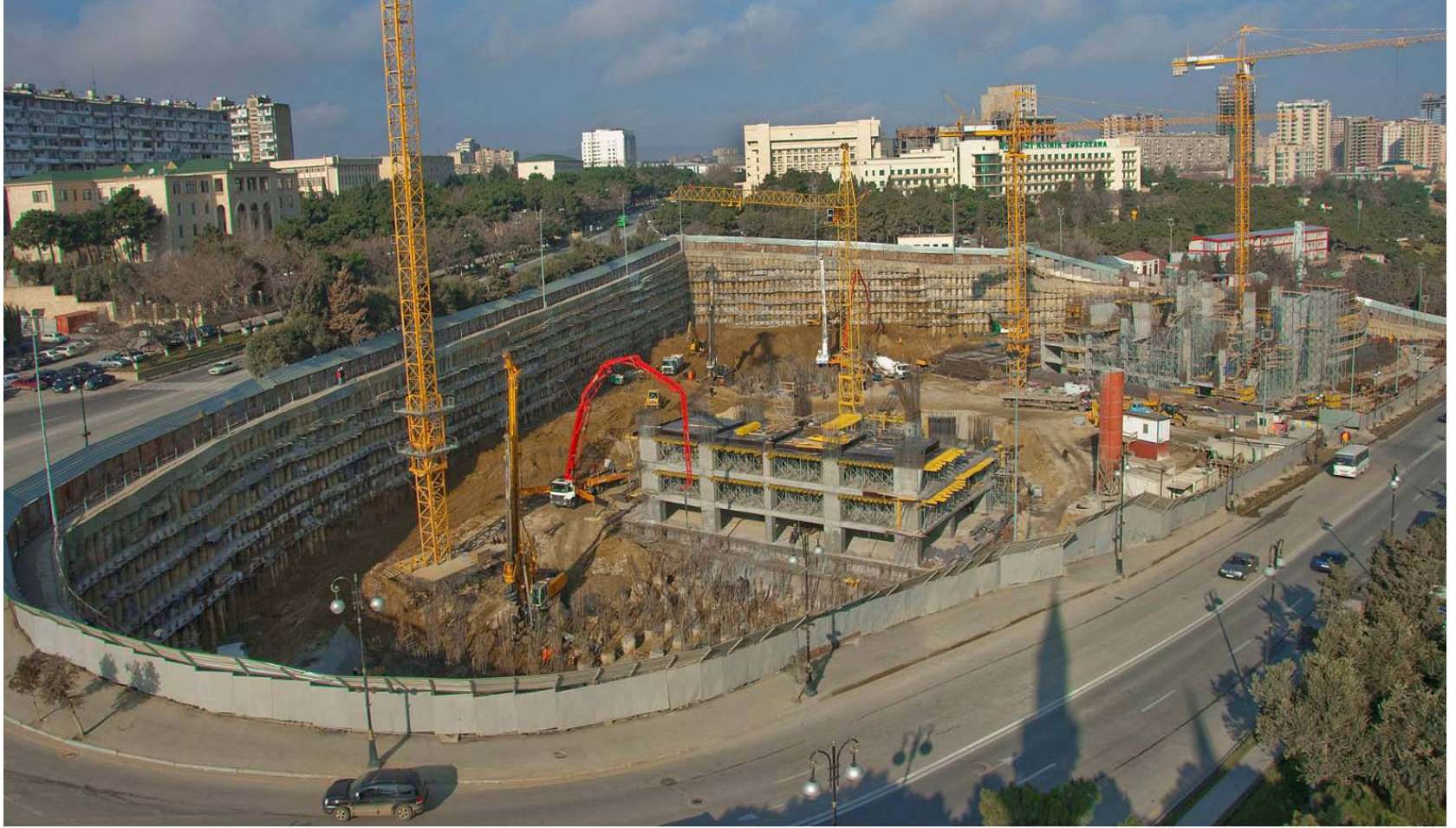
Şekil A.17 : Flame Towers iksa sistemi güneyden görünüş
