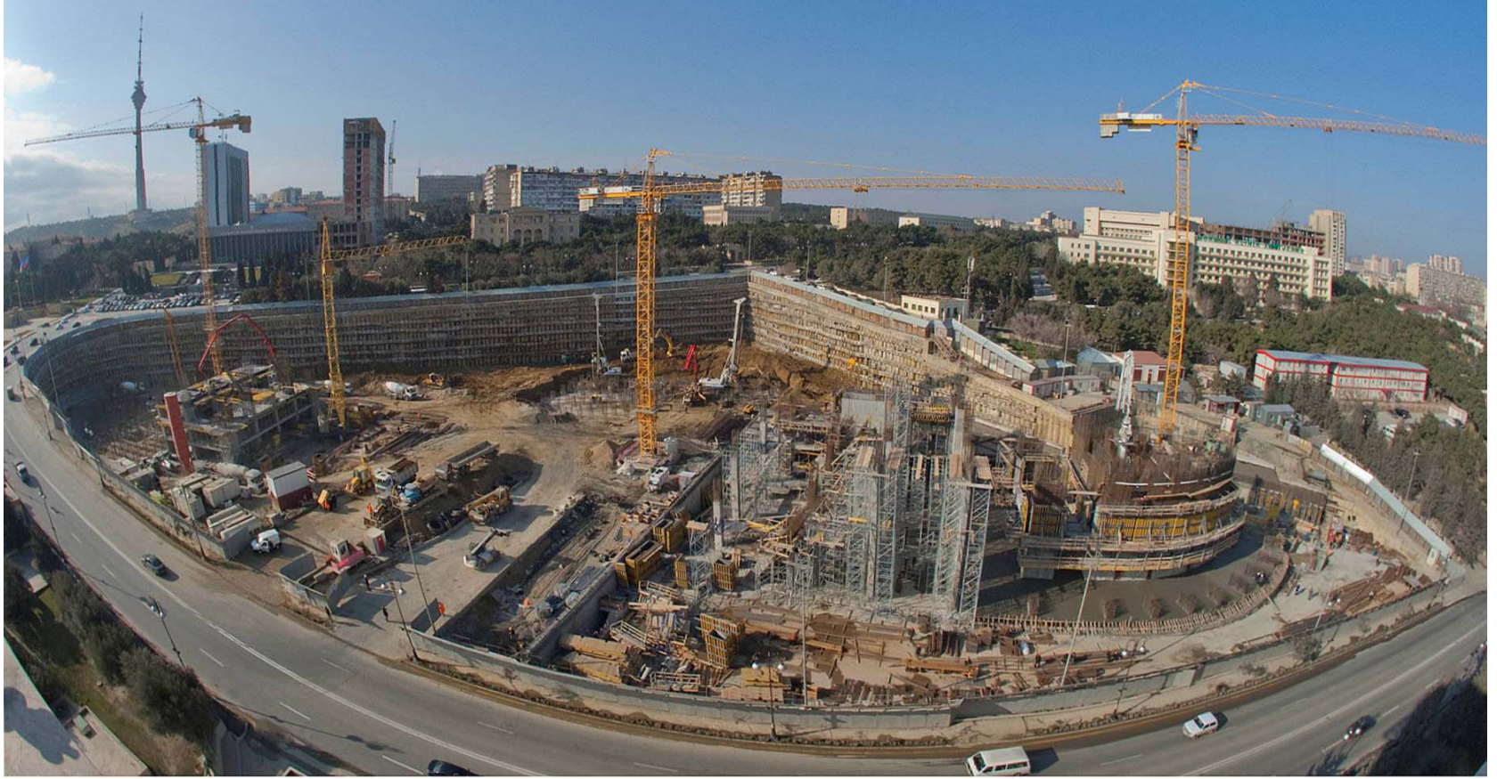
Şekil A.18 : Flame Towers iksa sistemi doğudan görünüş
