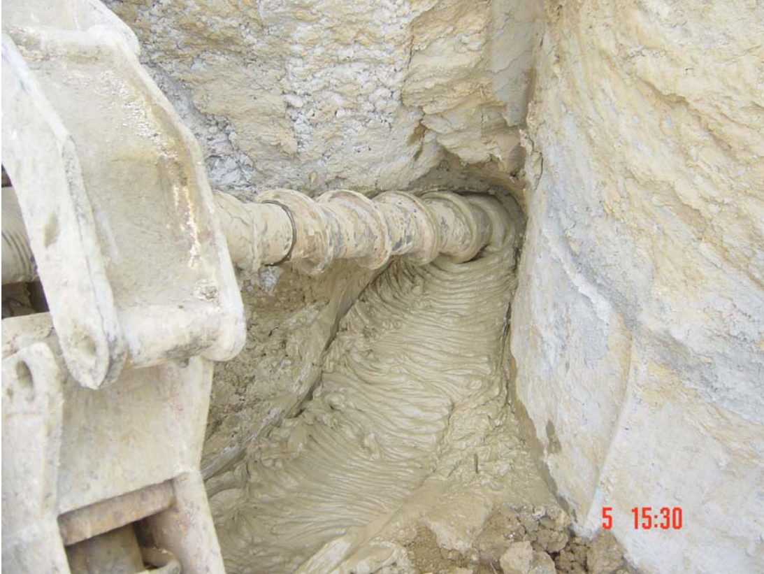
Şekil 8.14 : Balçık kıvamında zemin
