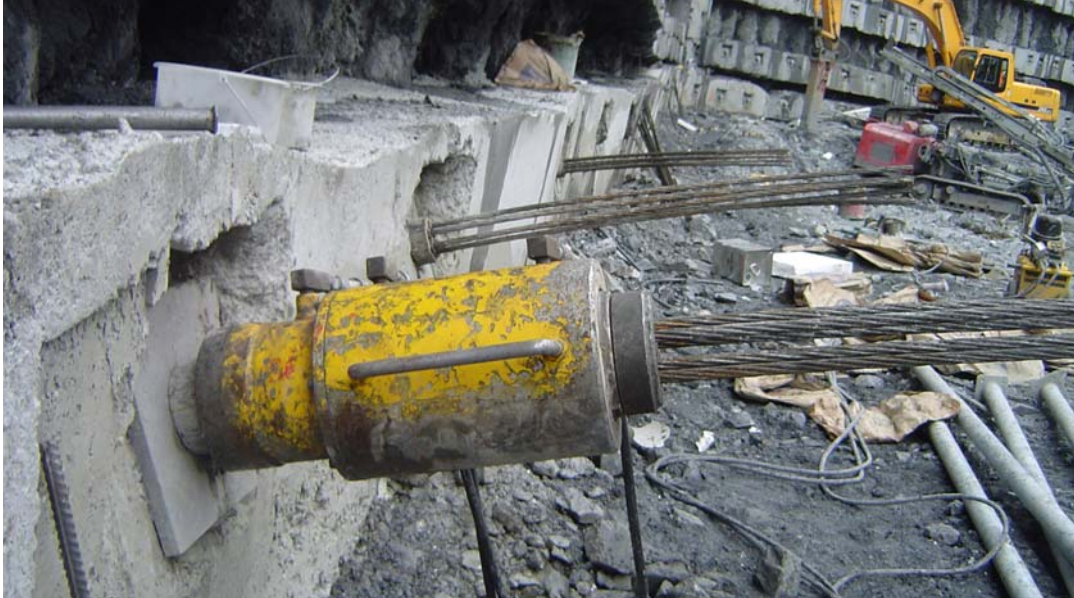
Şekil 5.5 : Ankraj germede kullanılan hidrolik kriko
