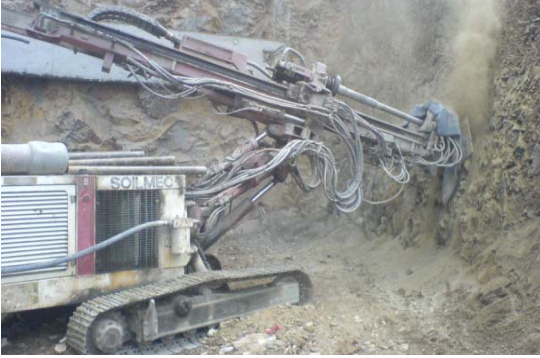
Şekil 3.7 : Ankraj imalatı
