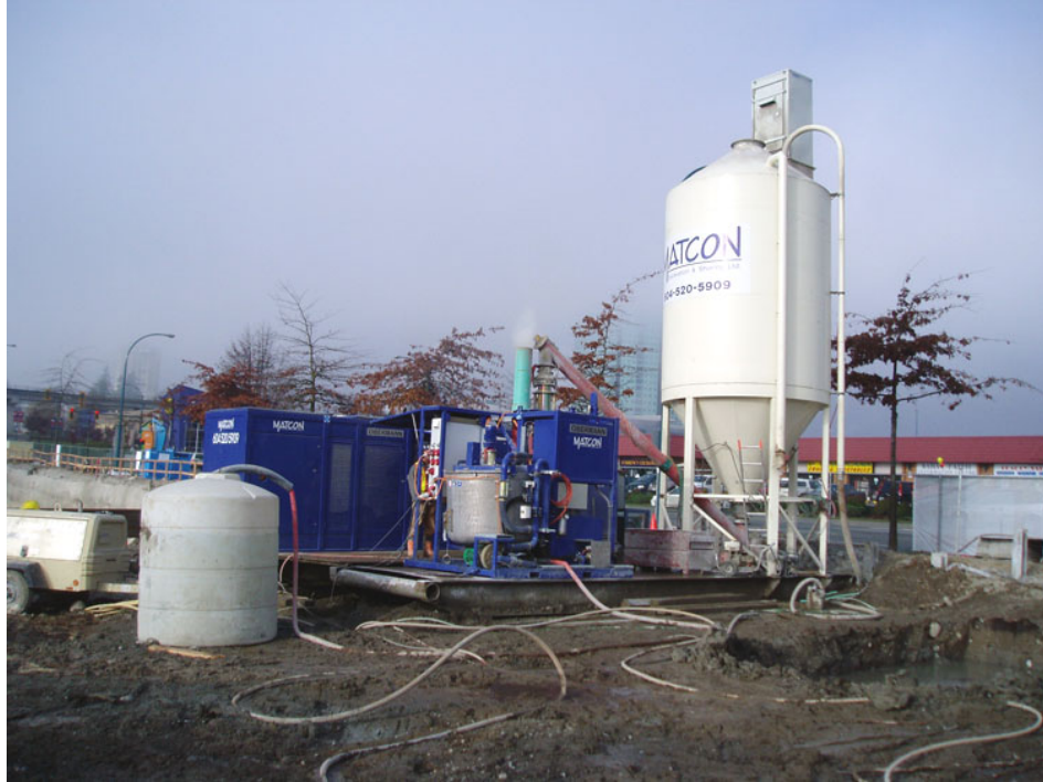
Şekil 2.7 : Jetgrout pompa ünitesi, çimento silosu ve mikser ünitesi
