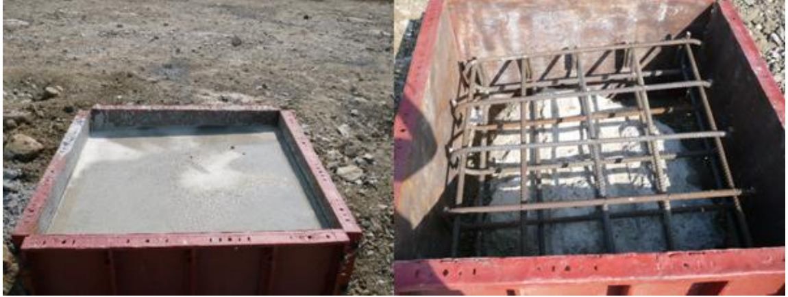
Şekil 4.1 : Jetgrout kolon yükleme deneyi için başlık kirişi hazırlanışı
