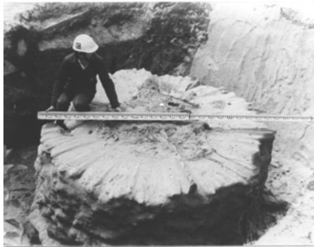
Şekil 3.26: Geniş çaplı jetgrout kolonu
