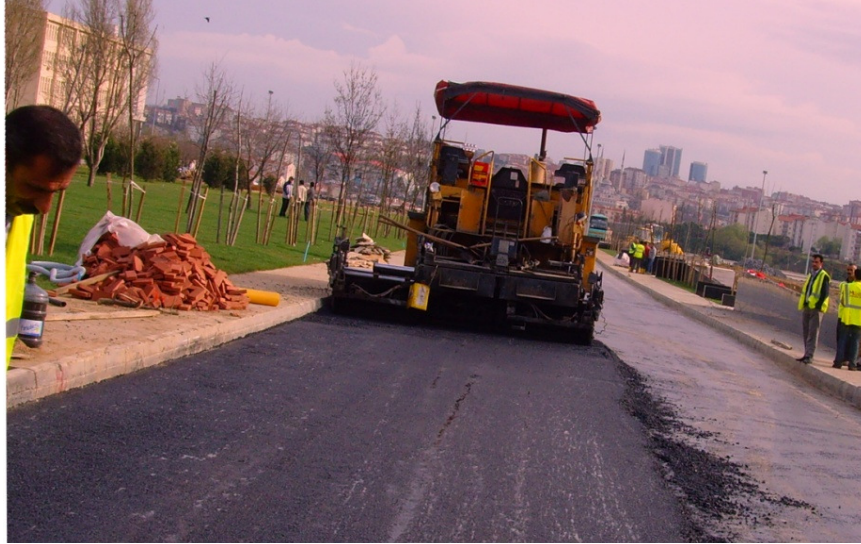
Şekil 6. 25 : Finişer ile serim yapılması I
