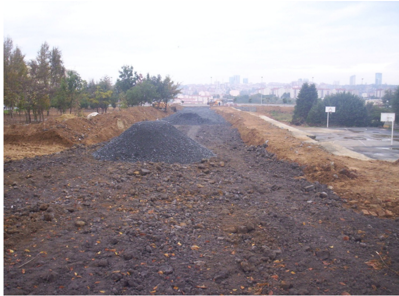
Şekil 6. 15 : Koruma tabakasının serilmesi
