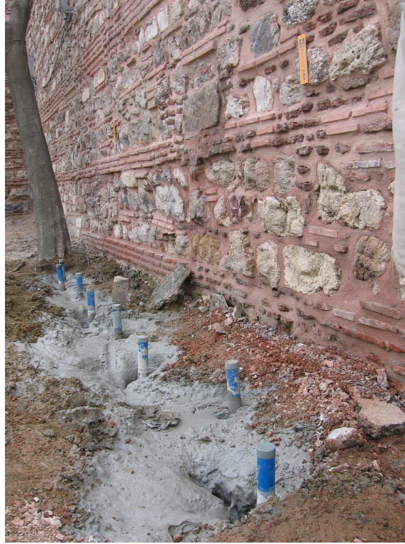
Şekil 2. 1 : Sodyum silikat – sodyum alimunat enjeksiyonu
