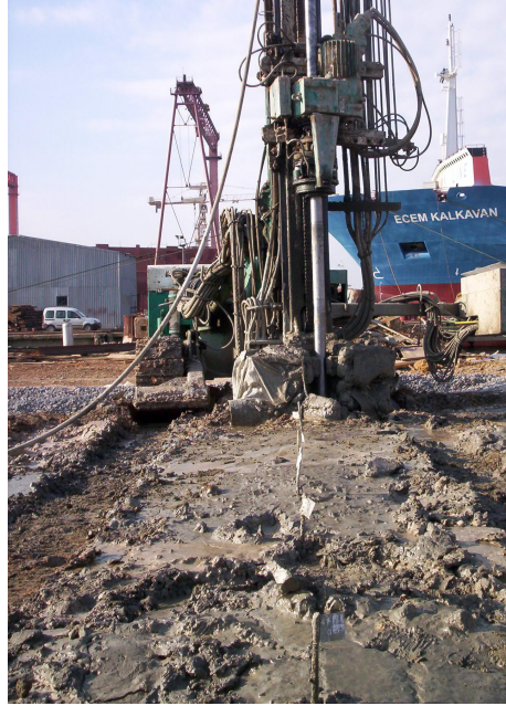
Şekil 2. 2 : Jet grout uygulaması
