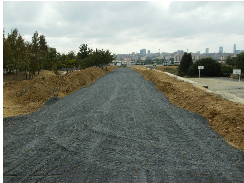
Şekil 6. 12 : Serim ve sıkıştırma sonrası alttemel tabakası
