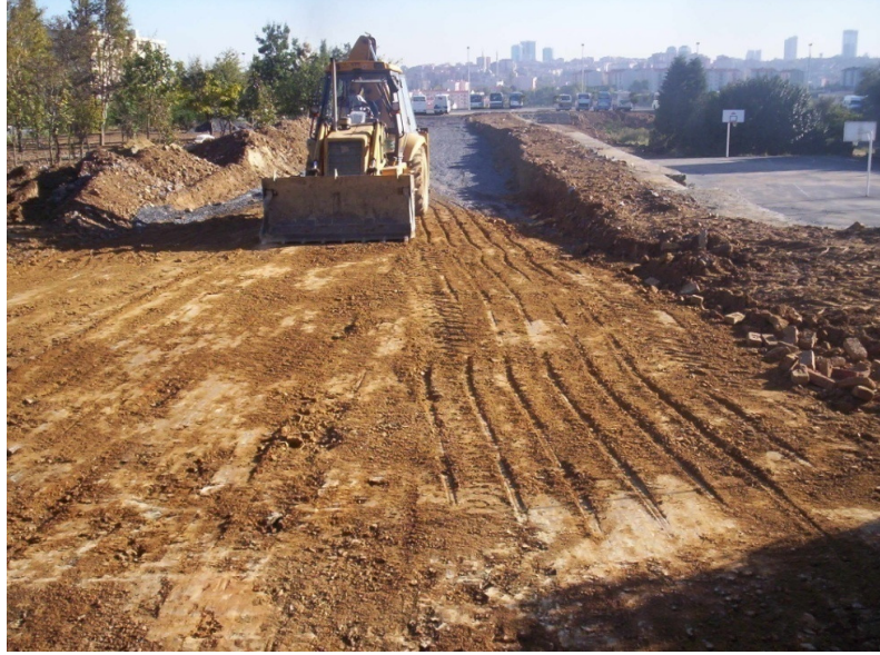
Şekil 6. 11 : Alttemel malzemesi serimi
