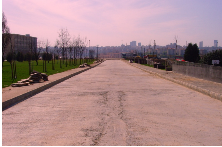
Şekil 6. 22 : Basınçlı su kullanılarak temizlenen yol
