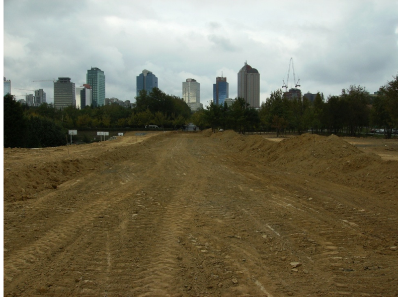
Şekil 6. 10 : Kazı sonrası yol görünümü
