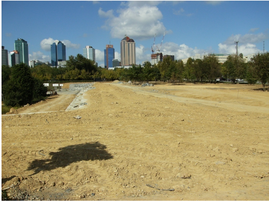
Şekil 6. 8 : Sıyırma sonrası inşaat alanı
