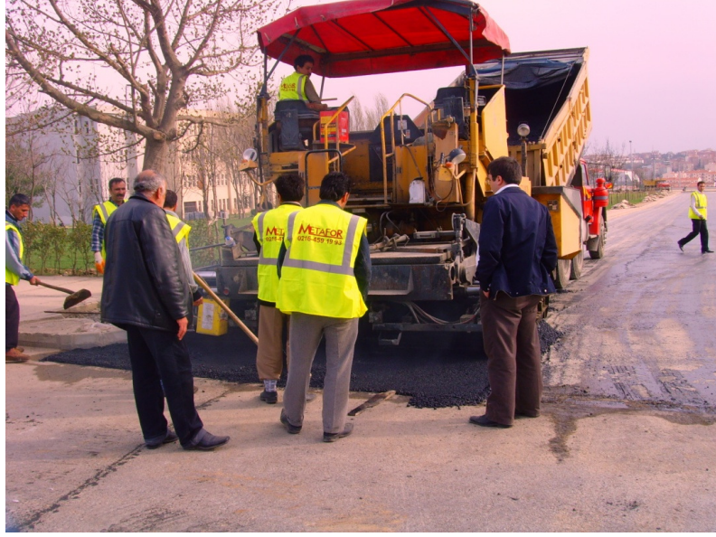
Şekil 6. 24 : Finişer ile serime başlanması
