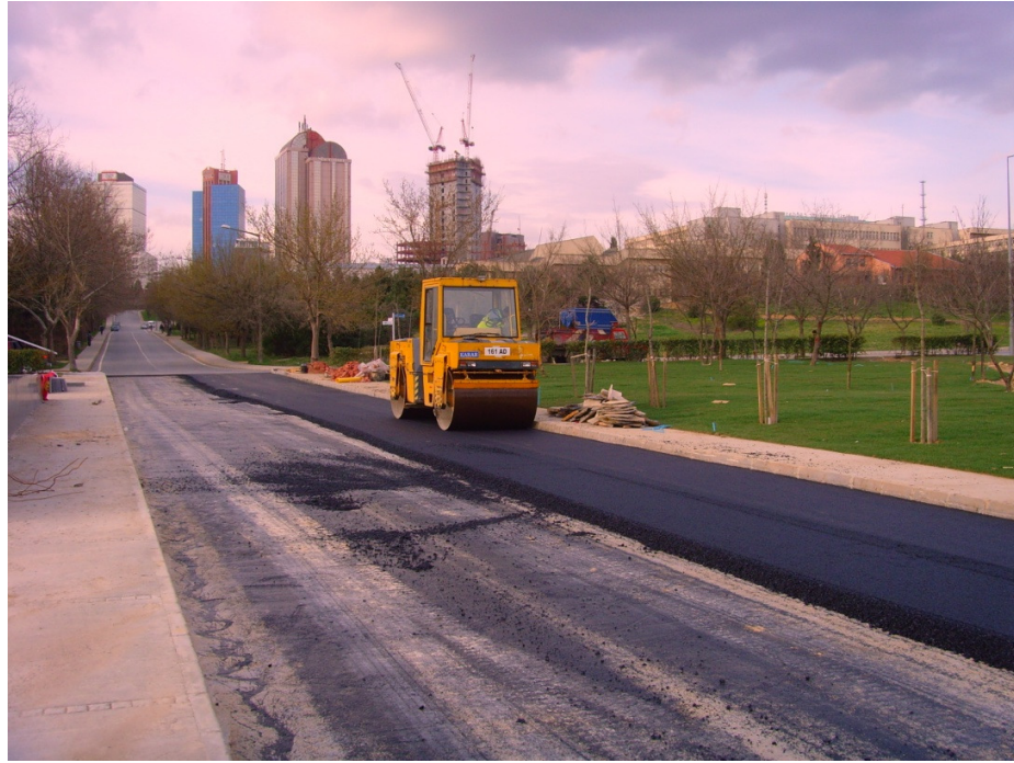
Şekil 6. 28 : Sıkıştırılmanın yapılması
