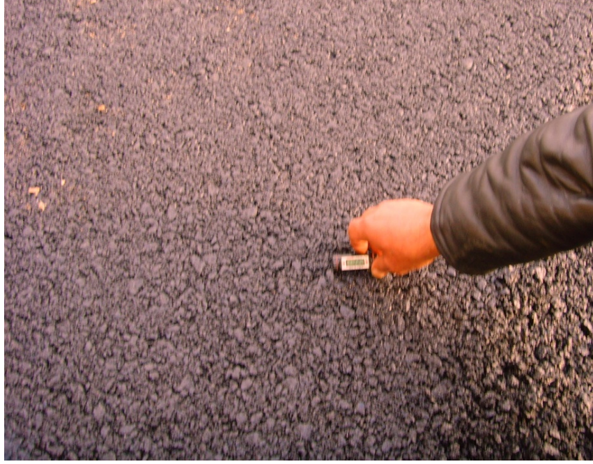
Şekil 6. 27 : Asfaltın sıcaklık ölçümü
