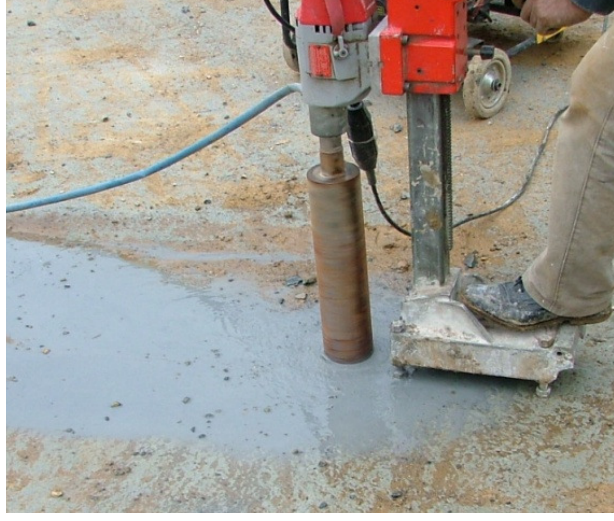
Şekil 6. 20 : Beton temelden karot alınması
