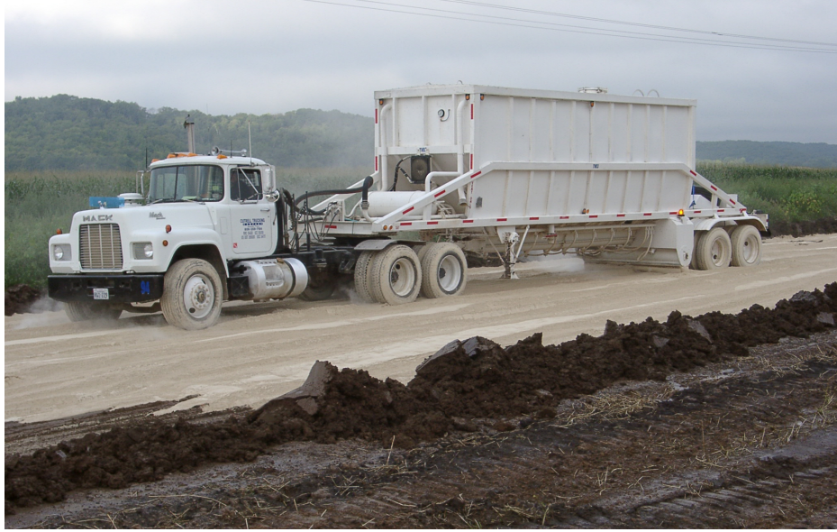
Şekil 4. 1 : Uçucu külün zemin iyileştirmesi için araziye getirilmesi (Edil, vd., 2000 ve 2002)
