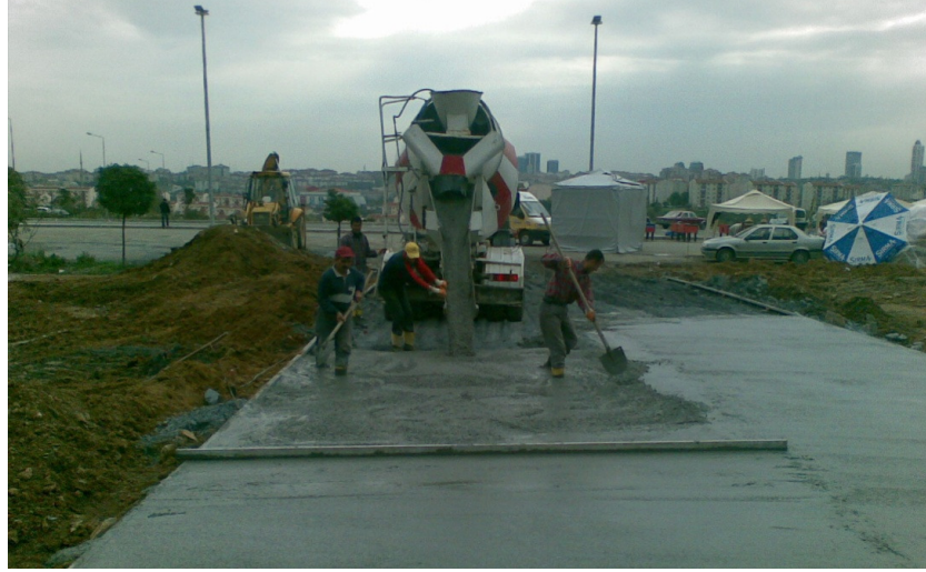
Şekil 6. 17 : Yolun beton temelini yapılması
