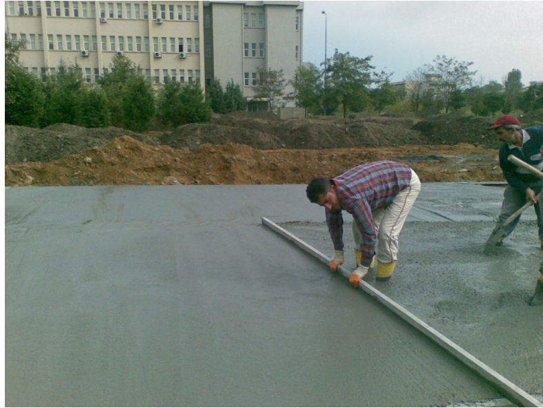
Şekil 6. 18 : Masterla betona perdah yapılması
