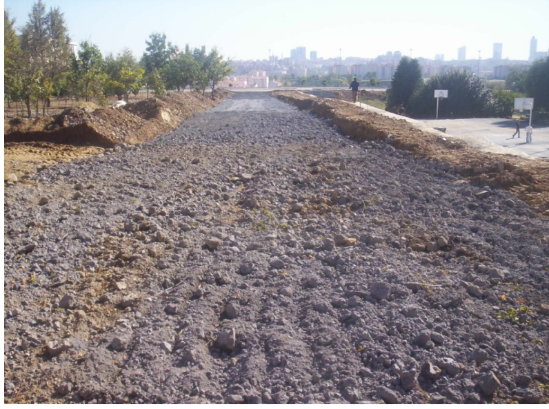
Şekil 6. 14 : Cüruf temel tabakası serimi sonrası yol görünüşü
