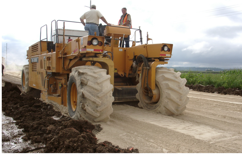
Şekil 4. 2 : Uçucu kül ile zemin stabilizasyonu (Edil, vd., 2000 ve 2002)
