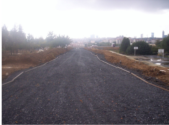
Şekil 6. 16 : Kalıplar çakılması ardından yolun görünüşü
