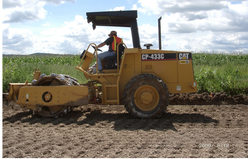
Şekil 4. 3 : Hazırlanan zemin – uçucu kül karışımının keçi ayakla sıkıştırılması (Edil, vd., 2000 ve 2002)
