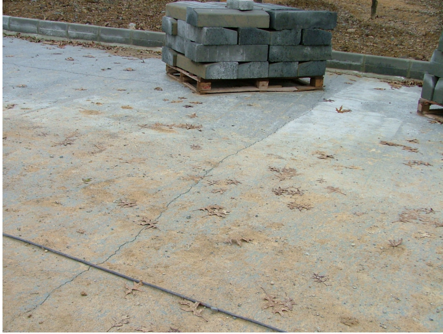
Şekil 7.7 : Cüruf kesitten kırmataş kesitine geçişte meydana gelen çatlama
