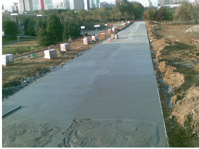
Şekil 6. 19 : Beton temelin tamamlanmış durumu
