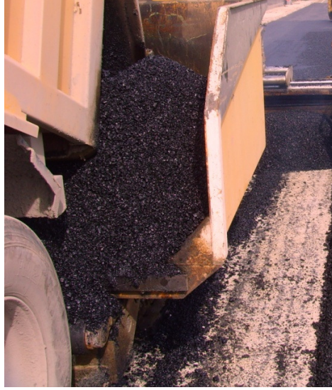
Şekil 6. 26 : Finişer ile serim II
