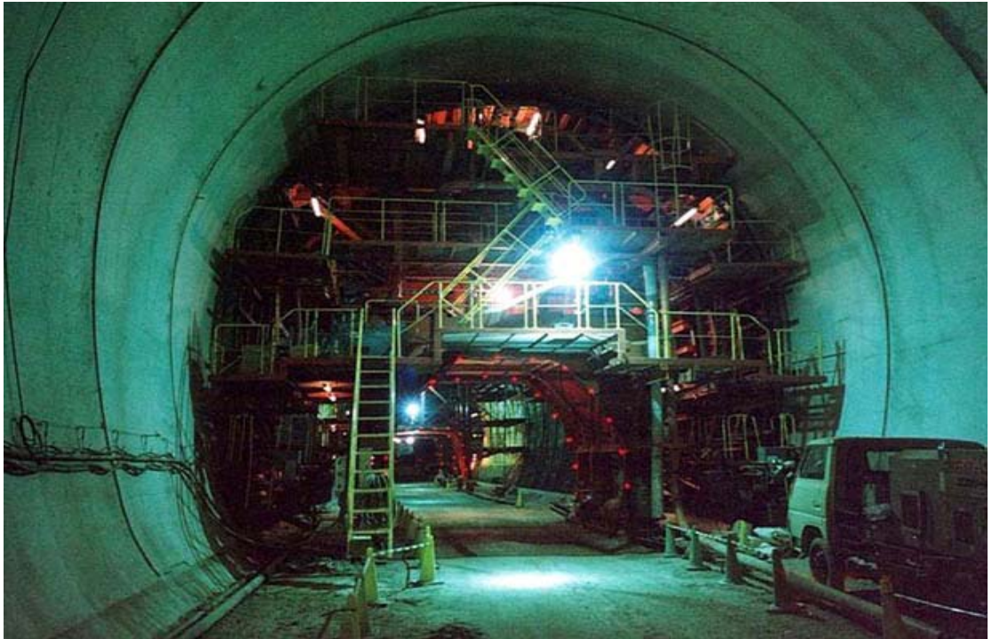
Şekil 4.7: NATM Tünel İnşa Yönteminde Son Kat Beton Kaplaması Yapılması [10]
