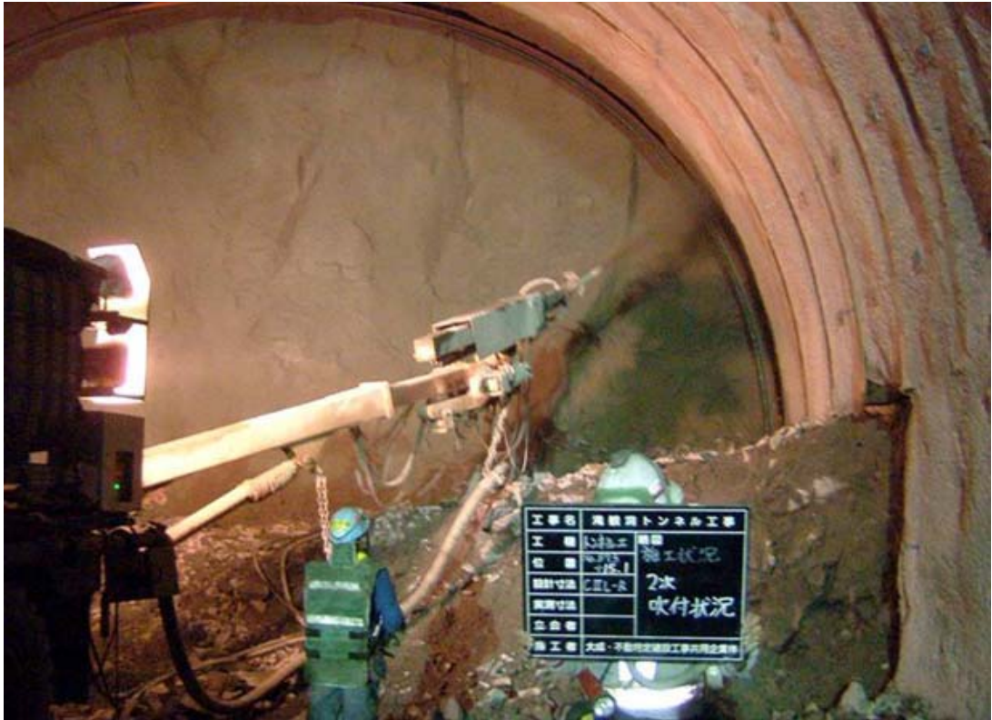
Şekil 4.5: NATM Tünel İnşa Yönteminde Püskürtme Beton Yapılması [10]
