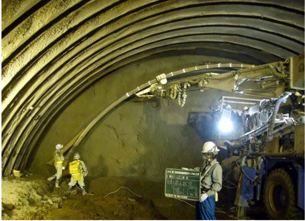
Şekil 4.4: NATM Tünel İnşaYönteminde İksa Yapılması [10]
