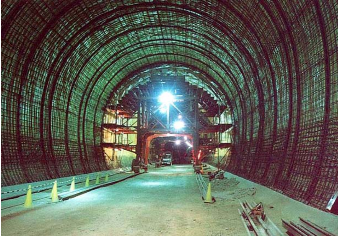
Şekil 4.6: NATM Tünel İnşa Yönteminde Çelik Hasır Kaplama Yapılması [10]
