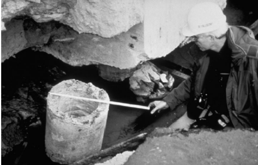
Şekil 5.7: 1995 Kobe Depremi: Kazıkta Meydana Gelen Kesme Hasarı (Finn ve Fujita, 2002)
