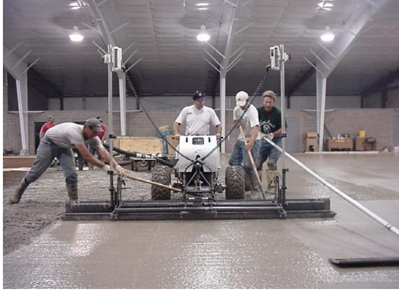
Şekil 2.13: Lazerli Master Kullanılarak Beton Yüzeyinin Düzeltilmesi
