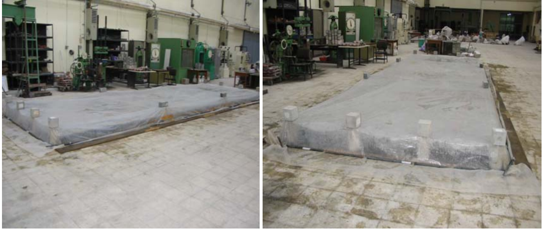
Şekil 4.3: Beton Yüzeyinin Su Geçirimsiz Örtü ile Korunması
