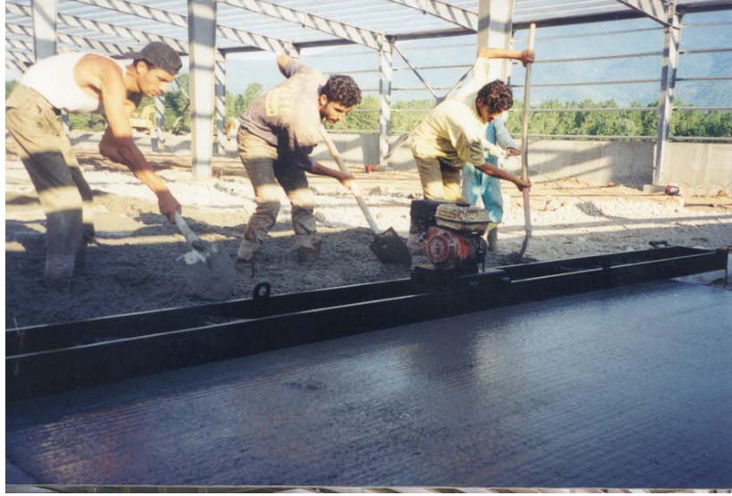
Şekil 2.12: Çerçeve Üzerinde Hareket Eden Vibratörlü Yüzey Mastarı
