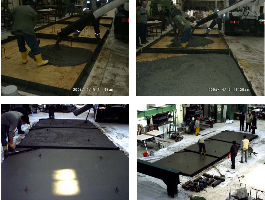
Şekil 6.2: ÇTDB Plakların Beton Dökümü
