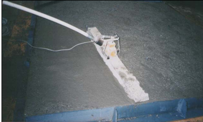
řekil 2.11: Vibratörlü Yüzey Masterı Yardımıyla Beton Yüzeyinin Düzeltilmesi
