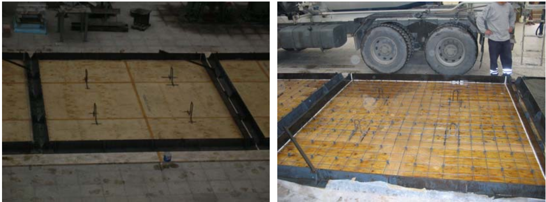
Şekil 6.1: Beton Döküm Düzeni
