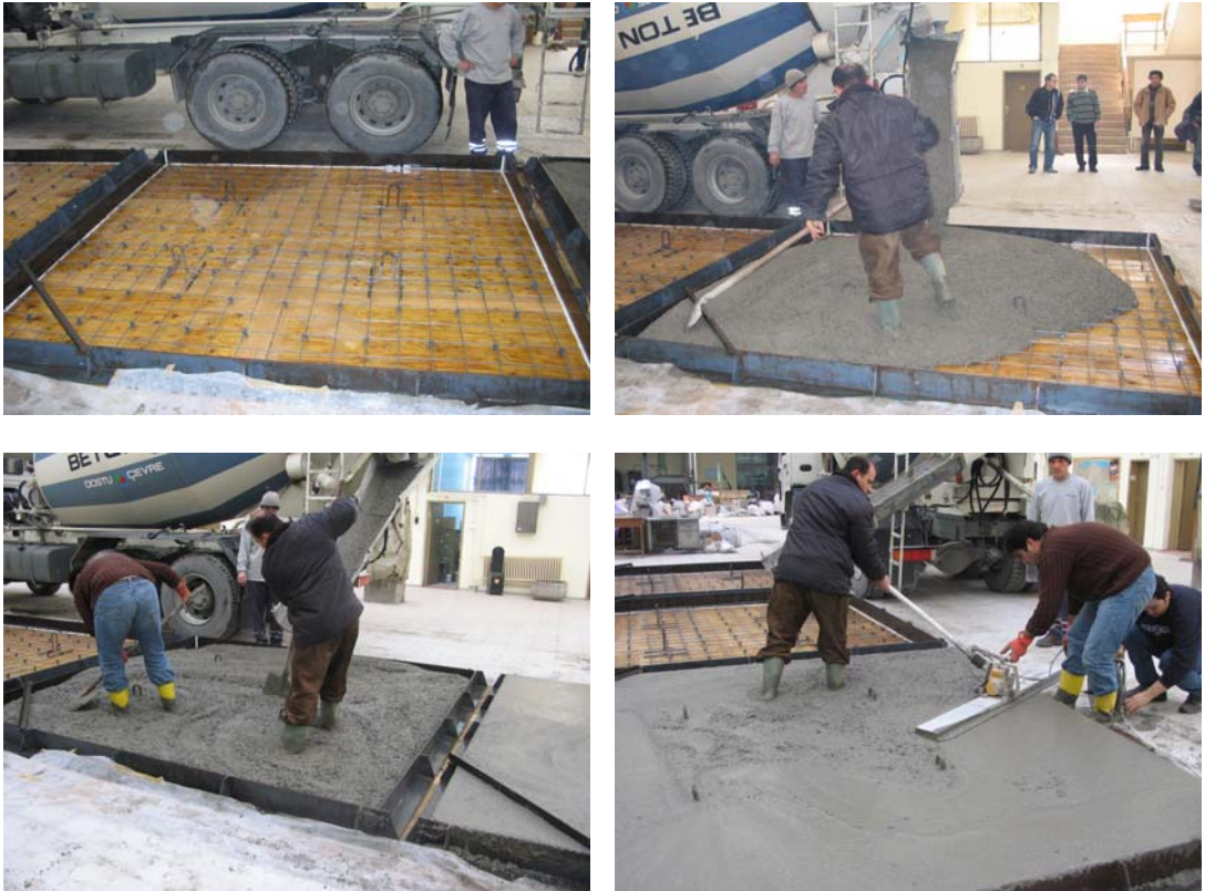
Şekil 3.5: Çelik Hasırların Kalıplara Yerleştirilmesi ve ÇHDB'nin Düzeltilmesi
