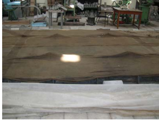
Şekil 4.2: Beton Yüzeyinin Islak Örtü ile Korunması
