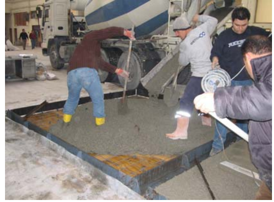
Şekil 6.3: ÇHDB Plakların Beton Dökümü
