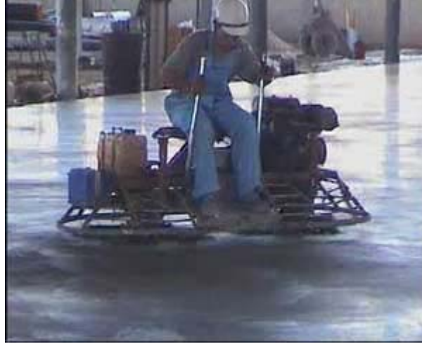
Şekil 2.14: Perdah Makinesiyle Beton Yüzeyinin Sıkıştırılması
