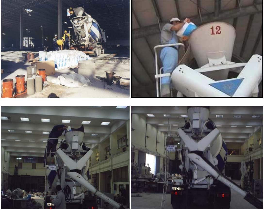
Şekil 2.9: elik Tellerin Transmiksere İlave Edilmesi
