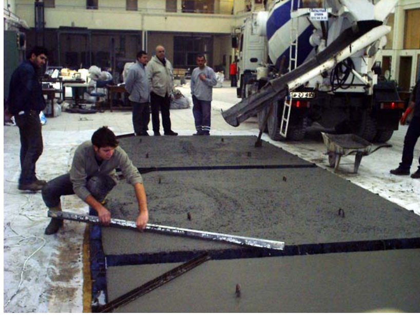
řekil 2.10: El Masterı Yardımıyla Beton Yüzeyinin Düzeltilmesi
