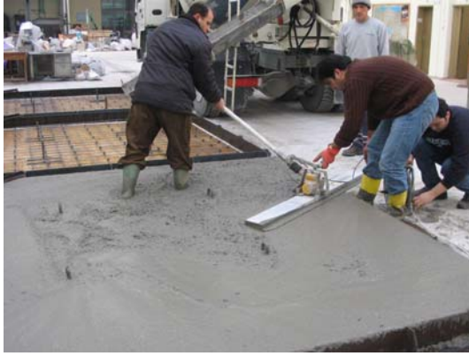
Şekil 6.3: ÇHDB Plakların Beton Dökümü
