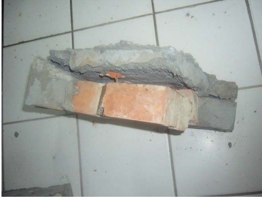
Şekil 4.24 : Standart Beton İle Takviye Edilmiş Tuğla Duvar Numunesi
