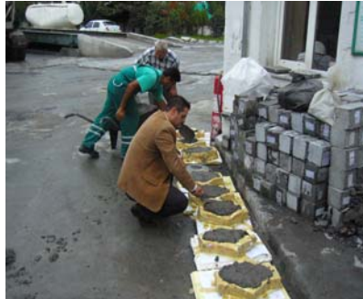
Şekil 3.24 : Model Tuğla Duvarların Tek Yüzlerinin Standart Beton İle Takviye Edilişi
