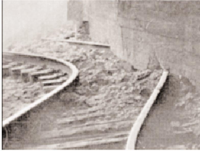
Şekil 2.3 : Kern County Demiryolu Raylarındaki Bükülme 1952, Kern County Depremi (Kontogianni ve Stiros, 2003)
