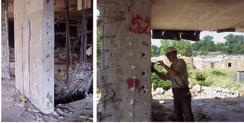
Şekil 8.7 : Patlayıcı Deliklerinin Açılması ve Patlayıcıların Yerleştirilmesi
