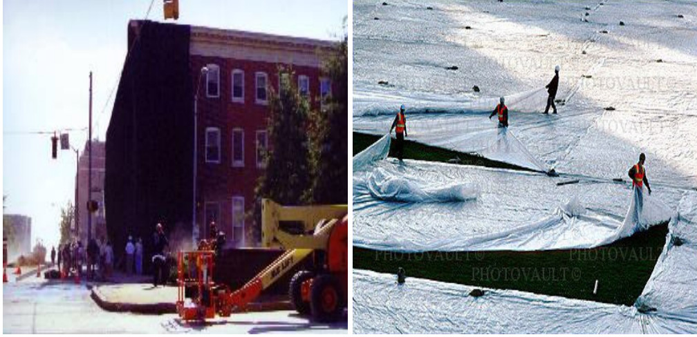
Şekil 3.15 : Patlatıcıyla Yapı Yıkımı Sırasında Çevredeki Yapıların ve Alanların Korunması
