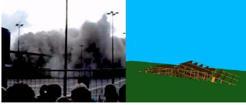
Şekil 7.9 : Yapıların Parçalı Olarak Yıkılması
