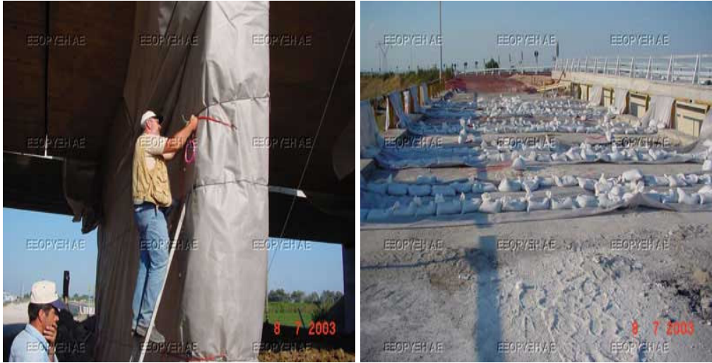
Şekil 3.16 : Patlatıcıyla Yıkılacak Bir Köprü Çalışmasında Etrafa Parça Fırlamasını Önlemek İçin Alınan Önlemler
