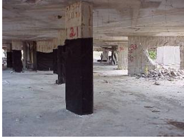
Şekil 8.9 : Yapı Elemanlarının Kaplanması
