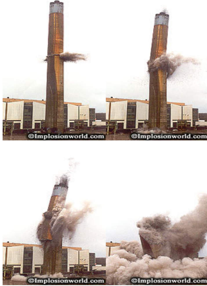
Şekil 8.21 : Bir Bacanın Yüksekliğinin Azaltılarak Devrilmesi
