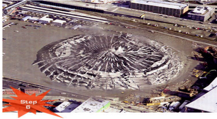
Şekil 7.1 : Yapının Kendi İçinde Çökmesi
