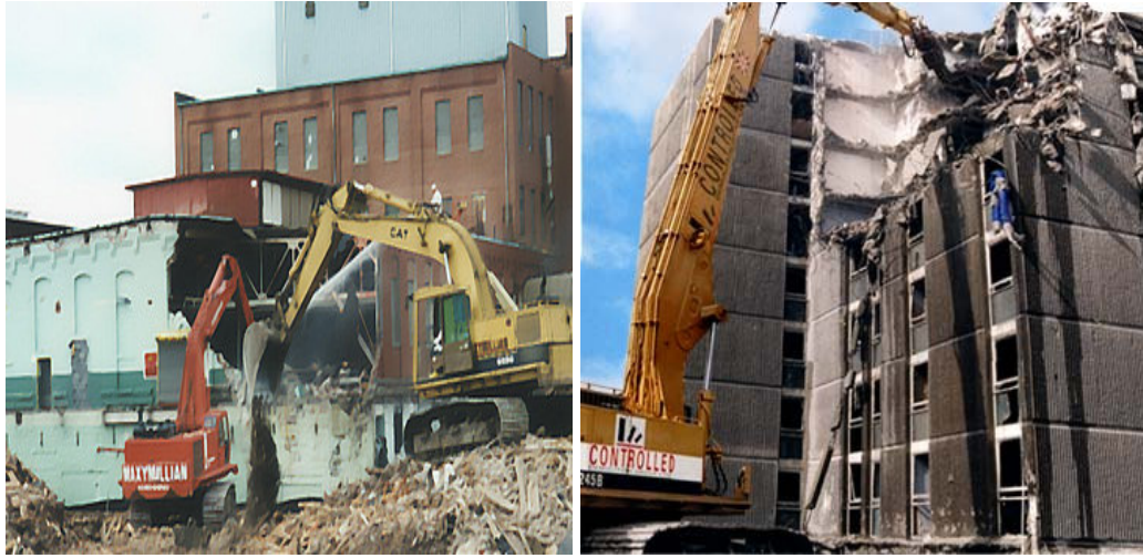
Şekil 2.1 : Mekanik Aletler ile Ezerek ve Kırarak Parçalama ile Yıkım
