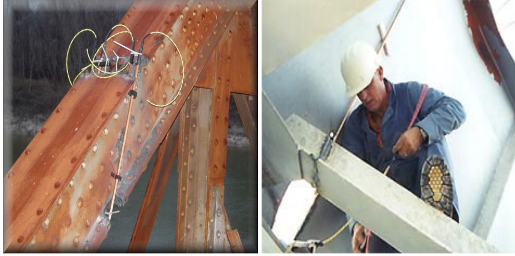
Şekil 8.13 : Çelik Yapılara Patlayıcıların Yerleştirilmesi
