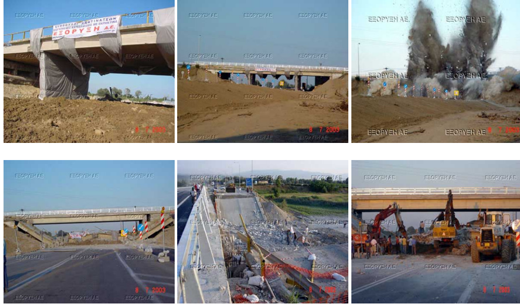
Şekil 8.30 : Prefabrike Kirişli Bir Betonarme Köprünün Patlatılması
