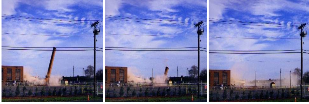
Şekil 8.17 : Tuğla Baca Yıkım Örneği
