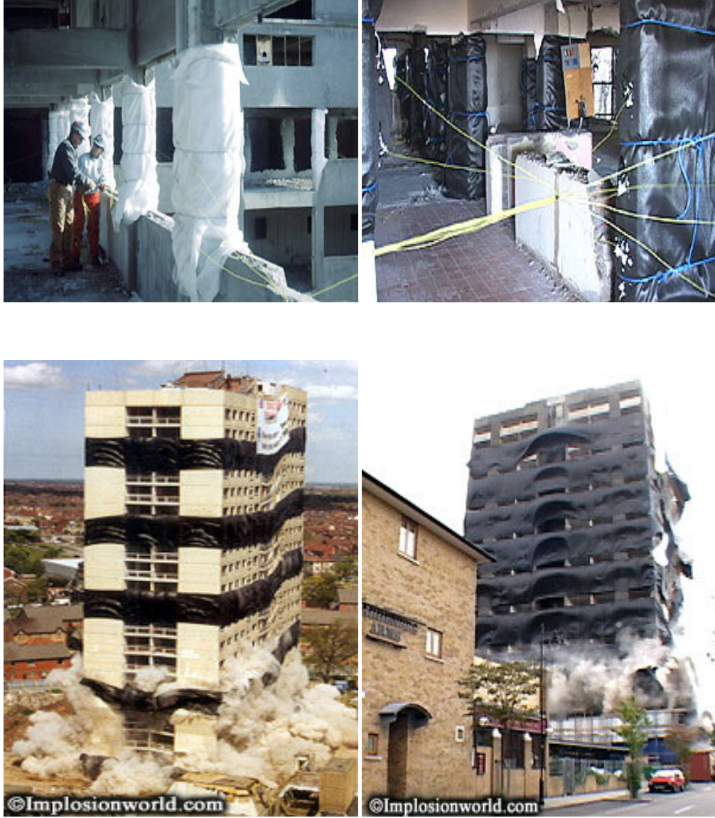
Şekil 3.14 : Patlayıcıyla Yapı Yıkımı Sırasında Patlatılacak Yapı Elemanlarının Koruyucu Malzemeyle Sarılması
