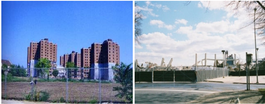
řekil 3.13 : Patlatılacak Yapıların Etrafının Tel itlerle vrilmesi
