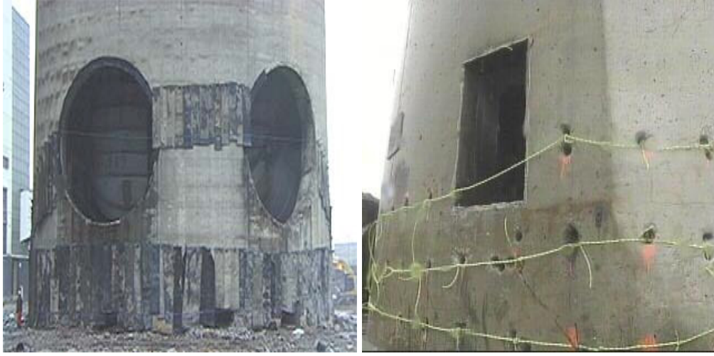
Şekil 8.19 : Bacalara Açılan Pencere
