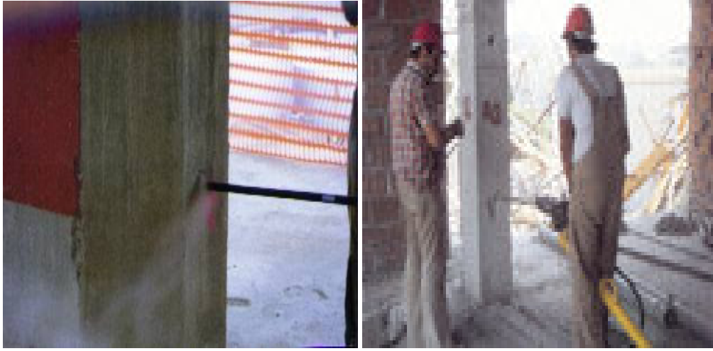
Şekil 3.10 : Patlatmalı Yıkım Çalışmasında Yatay Delik Delme İşlemi
