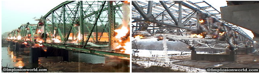
Şekil 8.26 : Çelik Köprülerin Patlatılması
