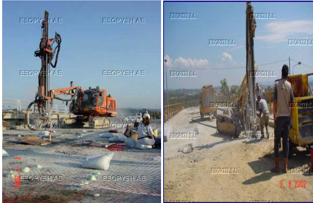
Şekil 3.12 : Betonarme Köprü Patlatılmasında Havallı Delici ile Delik Delme İşlemi Patlayıcılarla yapı yıkımında delik delme işlerinde planlama önemlidir. Çoğu zaman patlatılacak yapının katları arasındaki yapısal farklılıklardan dolayı her yapı elemanı
