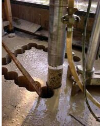
Şekil 8.2 : Döşemelerin Açılan Deliklerle Zayıflatılması
