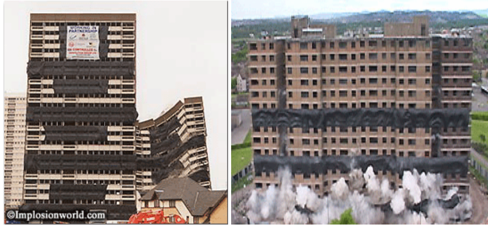
Şekil 8.10 : Dış Cepheye Açılan Boşlukların Kapatılması
