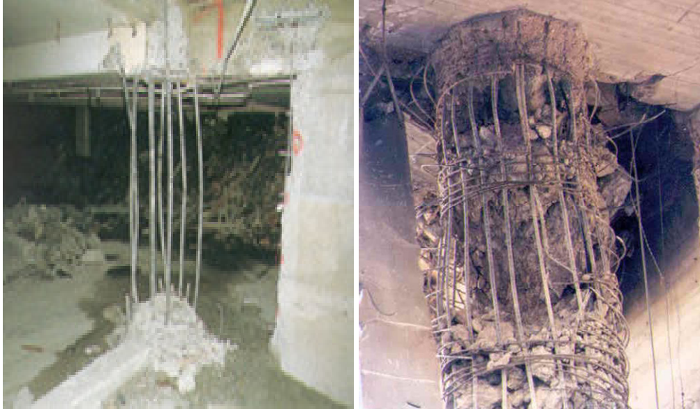
Şekil 4.1 : Yıkım Öncesi Seçilen Bir Kolonda Yapılan Test Patlatması
