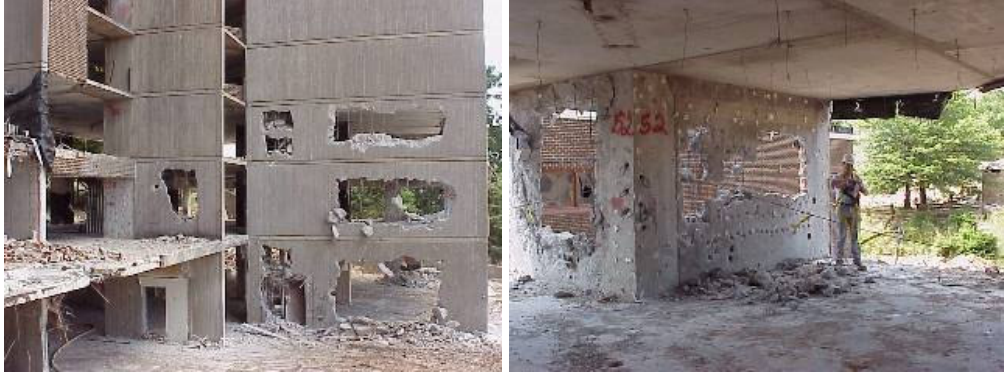
Şekil 8.11 : Duvarlarda Boşlukların Açılması
