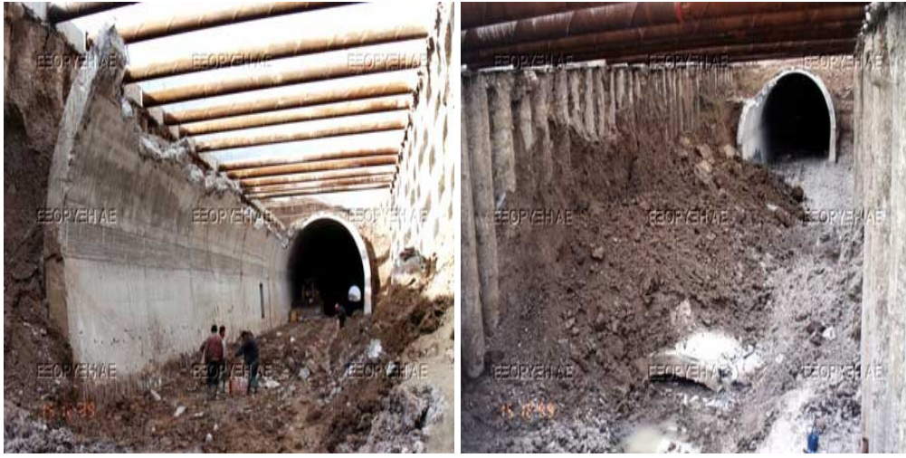
Şekil 8.34 : Mini Patlatma Uygulaması
