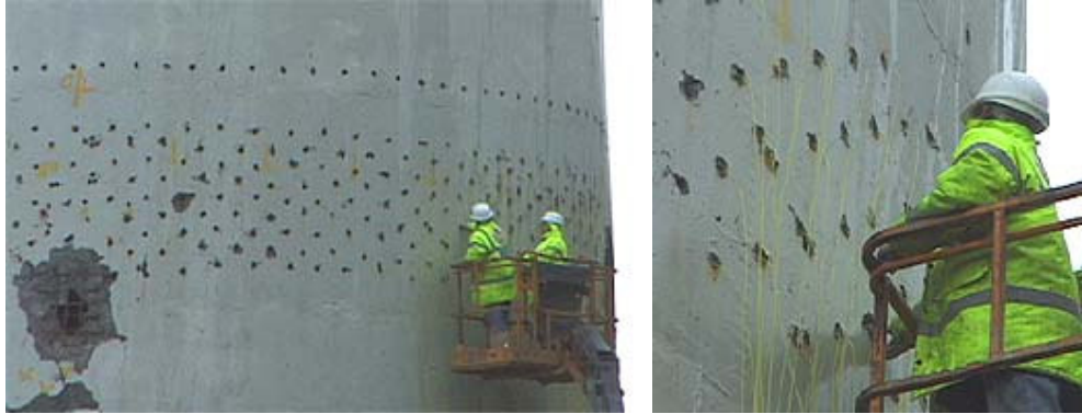
Şekil 8.23 : Açılan Baca Deliklerine Patlayıcı Yerleştirilmesi
