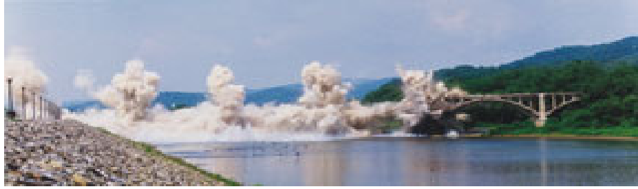
Şekil 8.28 : Kemer Kirişli Bir Betonarme Köprünün Patlatılması
