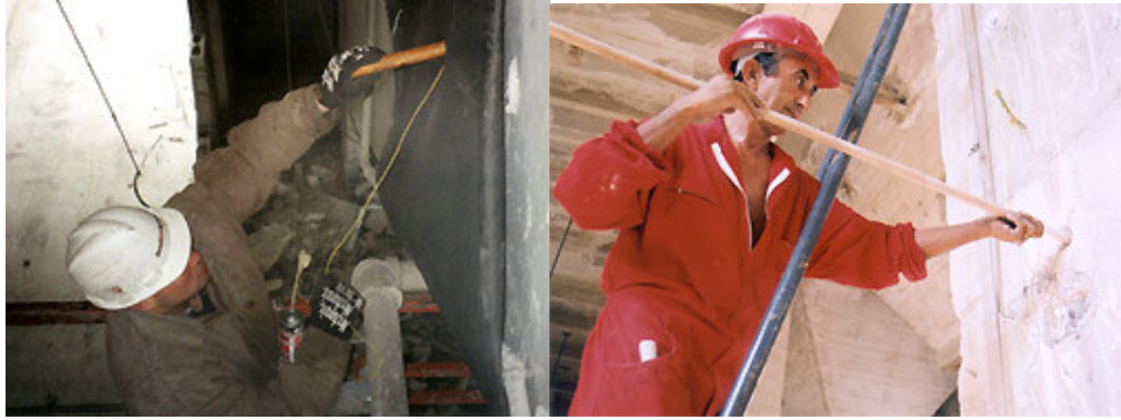
Şekil 8.8 : Patlayıcıların Yerleştirilmesi ve Sıkılama İşleme
