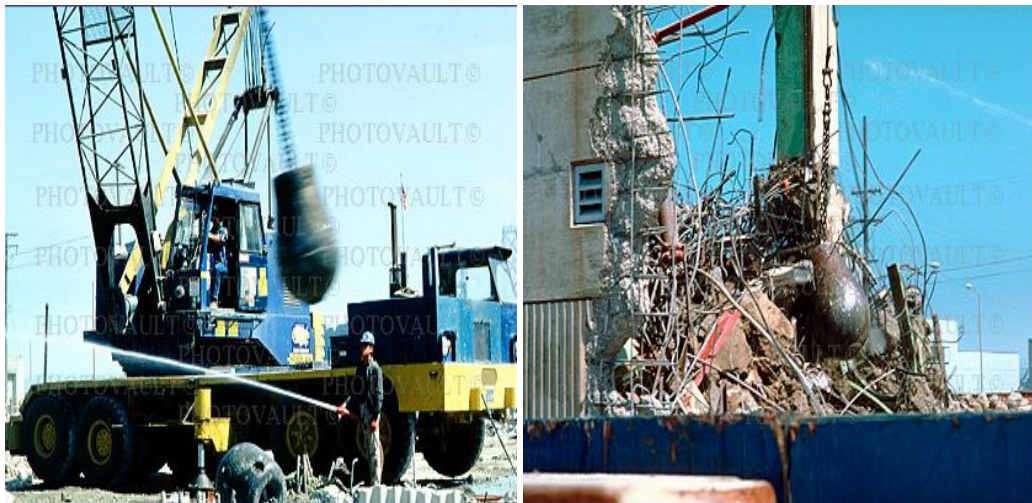
Şekil 2.2 : Bir Vince Bağlı Çelik Küre Yardımıyla Yapıya Vurarak Parçalama ile Yıkım
