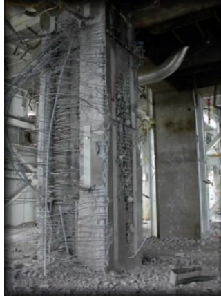
Şekil 8.1 : Kolonda Yapılan Test Patlatması
