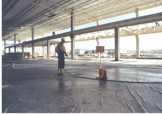
Şekil 4.2: Beton Yüzeyinin Islak Örtü ile Korunması
