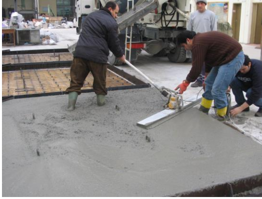
Şekil 6.3: ÇHDB Plakların Beton Dökümü
