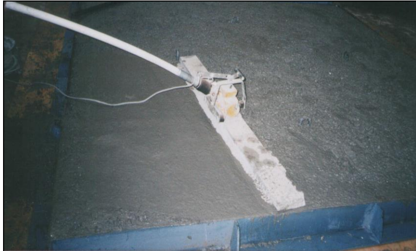
Şekil 2.11: Vibratörlü Yüzey Masterı Yardımıyla Beton Yüzeyinin Düzeltilmesi
