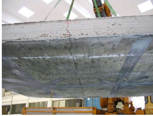
Şekil 7.37: P9 Plağının Alt Yüzeyinin Kırılma Sonrası Görünümü
