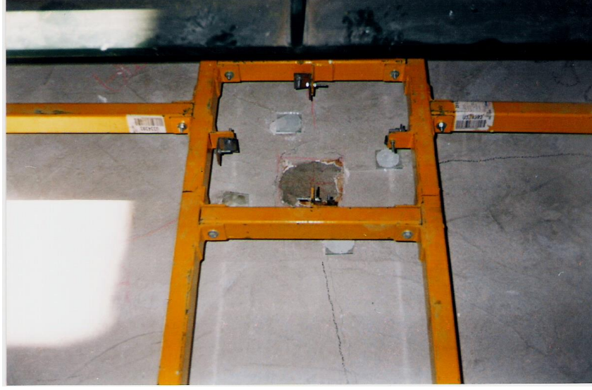
Şekil 7.8: P5 Plâğı Yükleme Sonrası Orta Noktanın Görünümü
