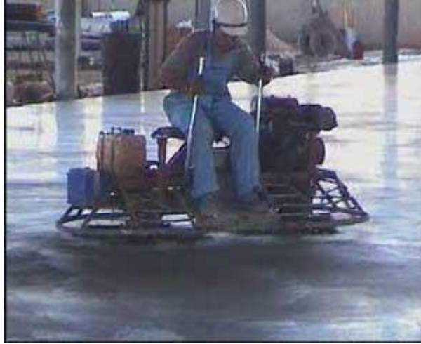
Şekil 2.14: Perdah Makinesiyle Beton Yüzeyinin Sıkıştırılması
