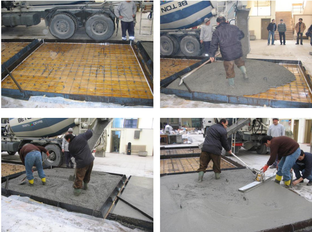
Şekil 3.5: Çelik Hasırların Kalıplara Yerleştirilmesi ve ÇHDB'nin Düzeltilmesi
