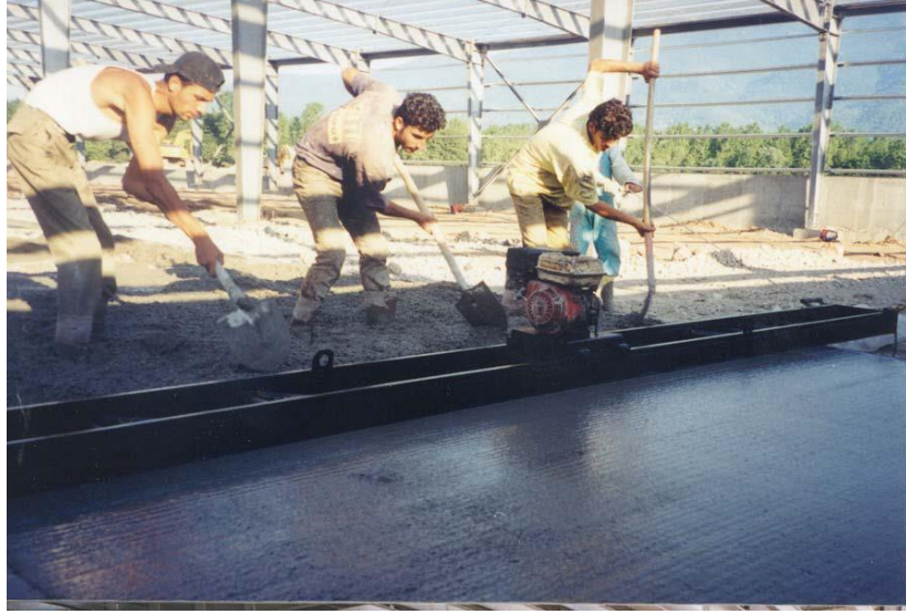
Şekil 2.12: Çerçeve Üzerinde Hareket Eden Vibratörlü Yüzey Mastarı
