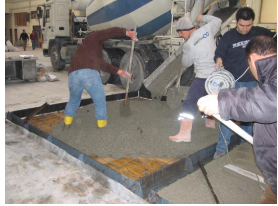
Şekil 6.3: ÇHDB Plakların Beton Dökümü
