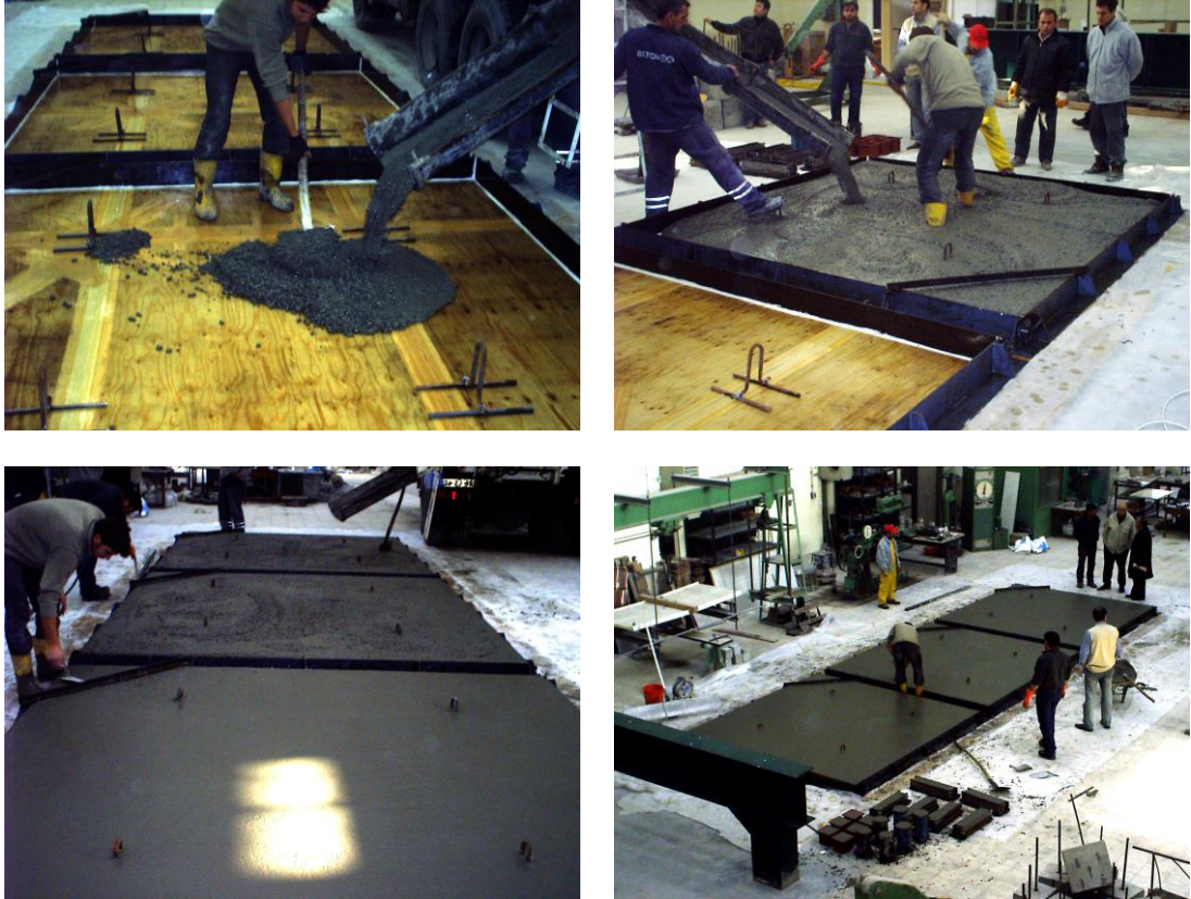
Şekil 6.2: ÇTDB Plakların Beton Dökümü
