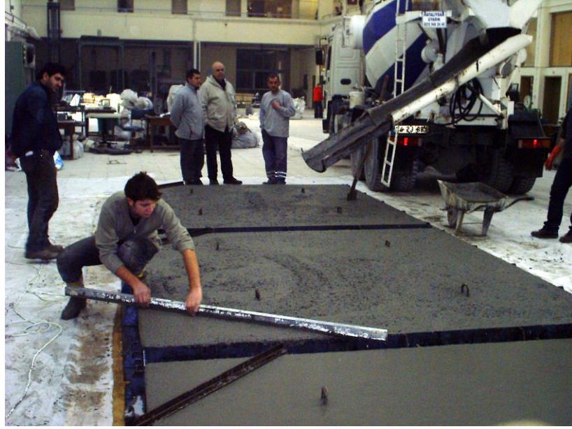
Şekil 2.10: El Masterı Yardımıyla Beton Yüzeyinin Düzeltilmesi
