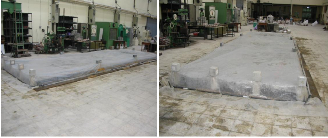
Şekil 4.3: Beton Yüzeyinin Su Geçirimsiz Örtü ile Korunması
