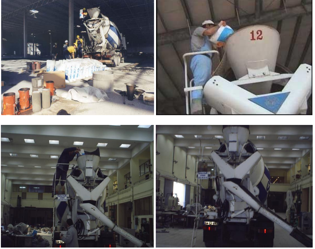
Şekil 2.9: elik Tellerin Transmiksere İlave Edilmesi
