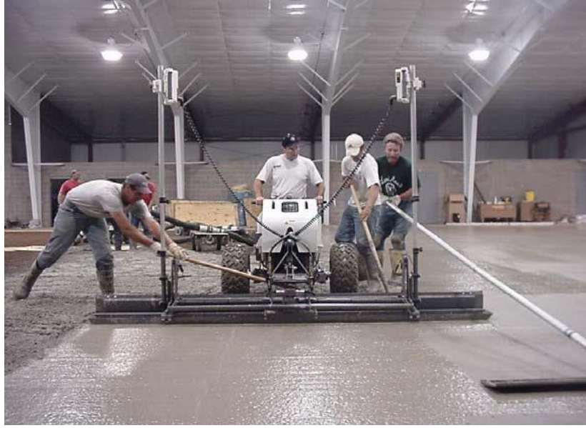
Şekil 2.13: Lazerli Master Kullanılarak Beton Yüzeyinin Düzeltilmesi
