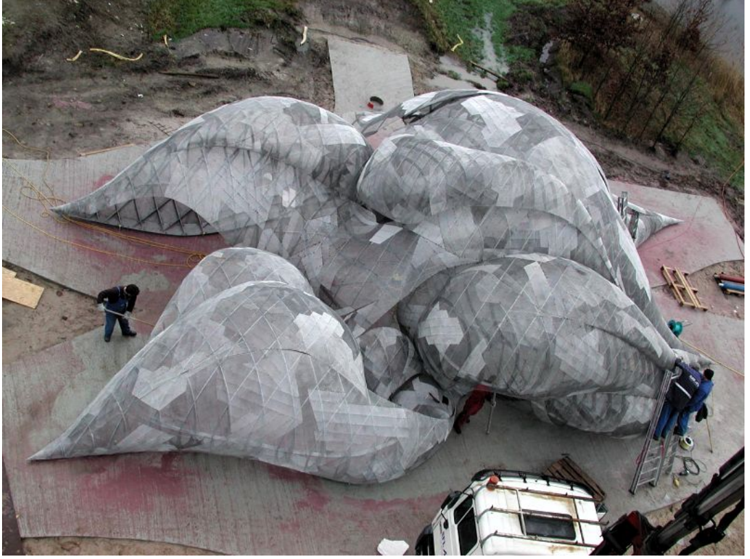
Şekil 3.14 Yapım aşamasında Son-O-House
