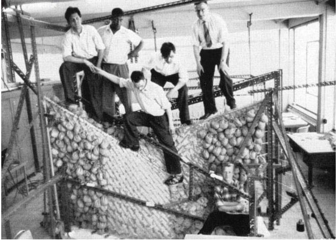
Şekil 3.20 Philips Pavyonu'nun inşaat süreci öncesinde büyük ölçekli maket üzerinde gerçekleştirilmiş stres testleri sırasında çekilen bir fotoğraf (Meyer, 2001)
