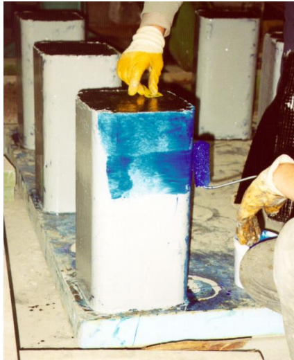
Şekil 3.10 Karbon lif tabakaları sarılmadan hemen önce epoksi esaslı yapıştırıcı sürülmesi
