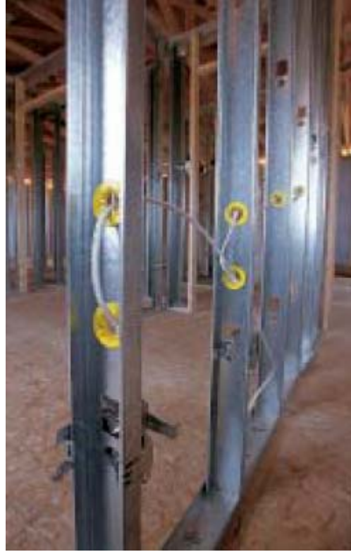
Şekil 4.10 Tesisat ve kablo için bırakılan boşluklar (Balac, 2002)
