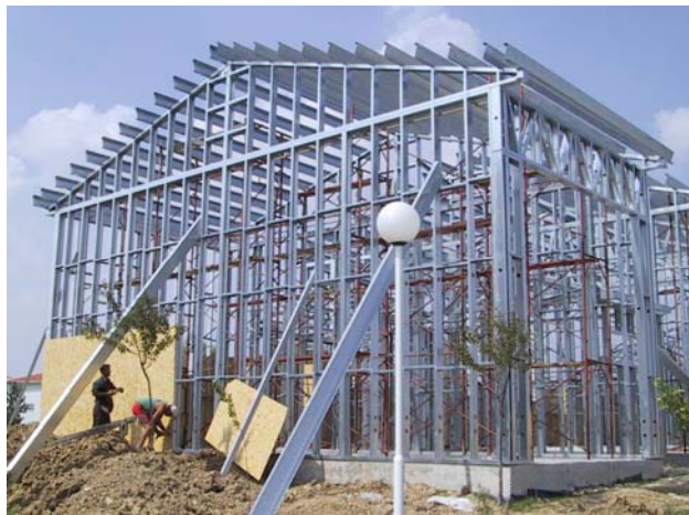
Şekil 2.1 Hafif çelik yapının genel görünüşü (Akşan A.Ş. Fotoğraf Arşivi, 2004)
