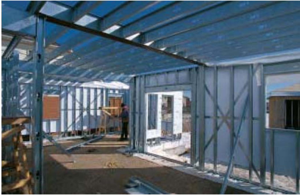
Şekil 4.21 X aprazlı perde duvar görünüşü (Balac, 2002)
