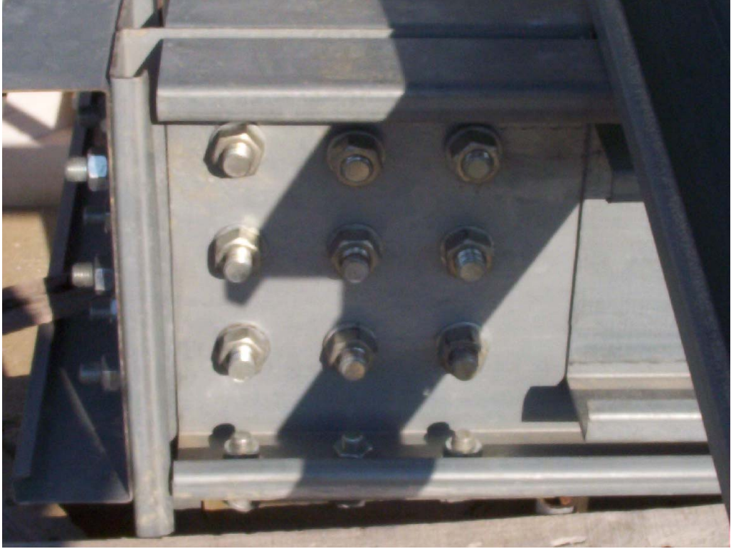
Şekil 4.20 Rijit birleşim detayı (Siyahhan, 2005)
