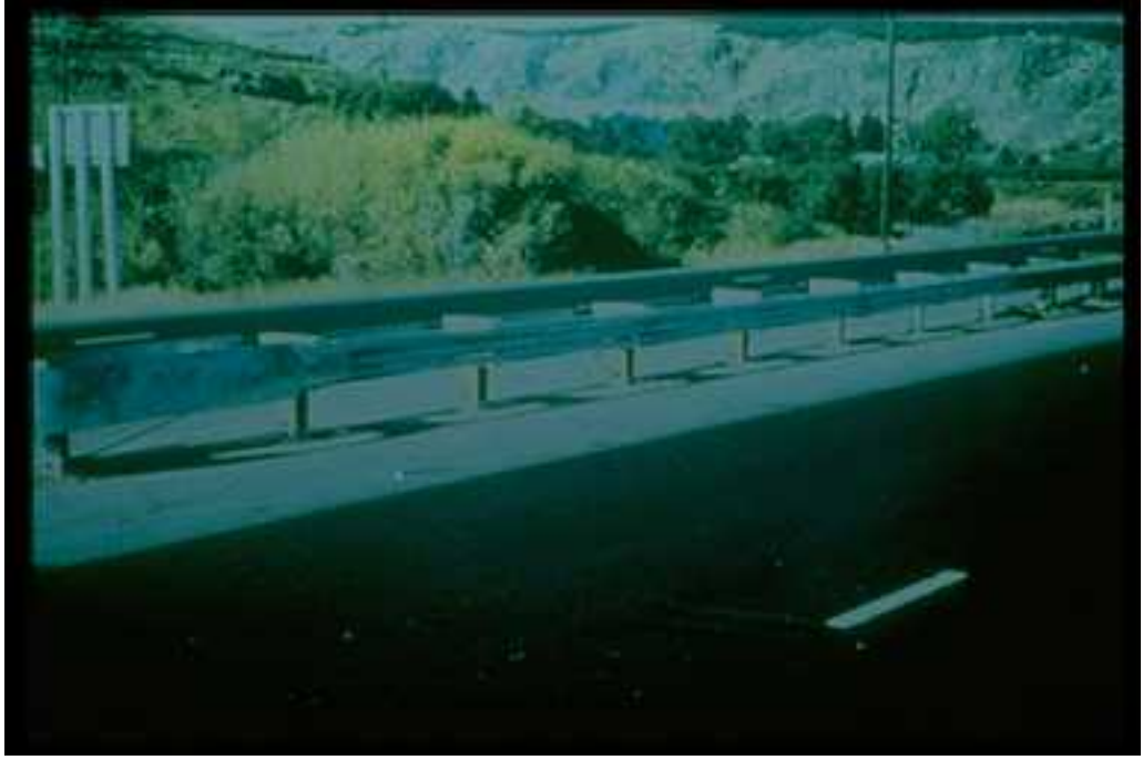
Şekil 2.2 Soğukta şekillendirilmiş profillerin menfez, korkuluk, bariyer işaretleri olarak kullanılması [2]
